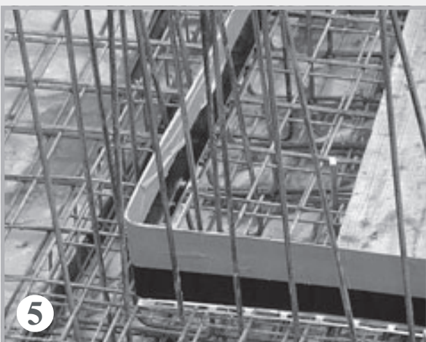
Befestigung mittels Bindedraht an der Halteschiene. Im Eckbereich einfach abbiegen
