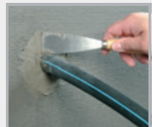
Verspachteln mit Schnellzement
