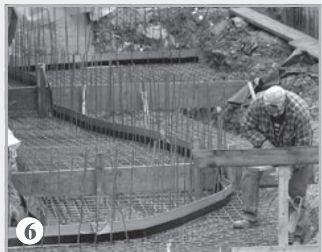
MASTER-Dichtblech macht alle Biegungen mit. Auch Abdichtungen durch versetzte Ebenen lassen sich problemlos ausführen.
