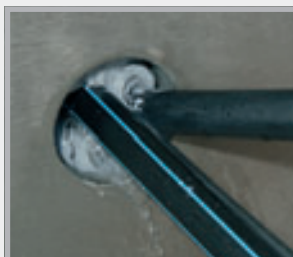
Füllen des Ringspalt
