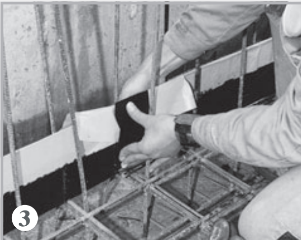
MASTER-Dichtblech 5 cm überlappen u. gegeneinanderdrücken
