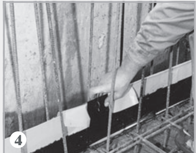
Sicherung der Verbindungsstelle durch eine Stoßklammer
