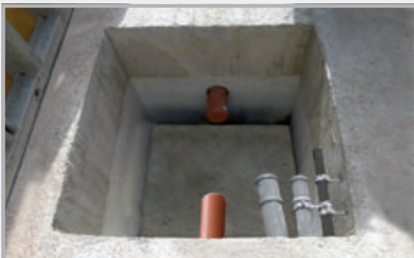
Nach der Betonage: Hellgrau erkennt man den Pumpensumpf, dunkelgrau die betonierte Sohle.
