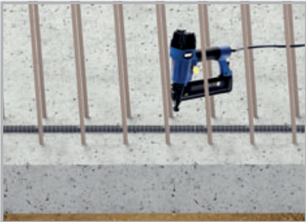
Verlegung mit Befestigungsgitter und Nägeln
