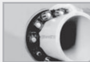
MASTER-SEAL in den Ringspalt einschieben
