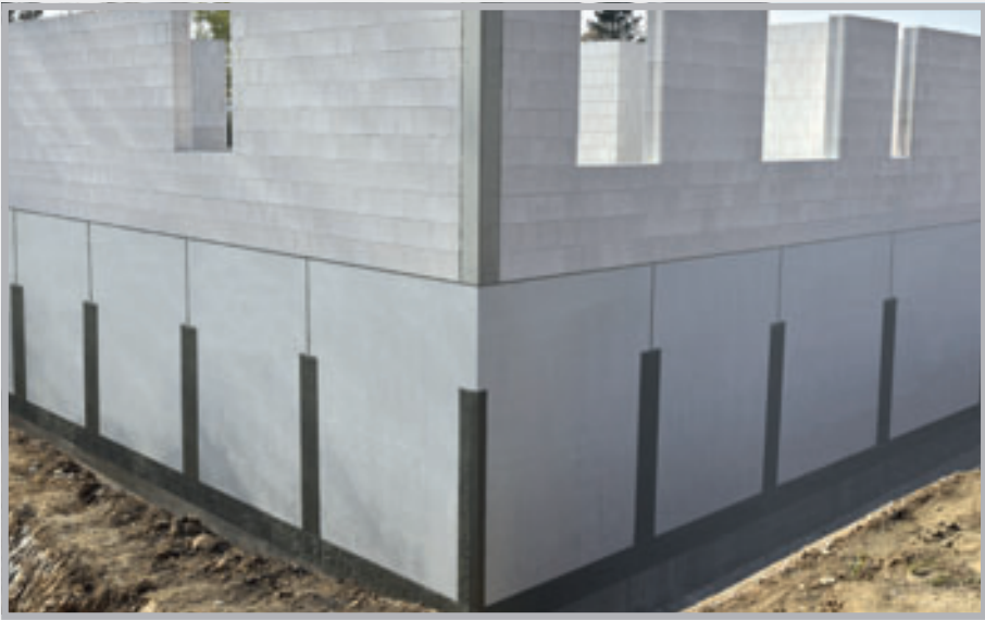
Abgedichtete Lagerungs- und Stoßfugen
