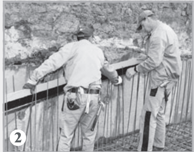
Aufstellen des Elementes auf die oberste Armierungslage
