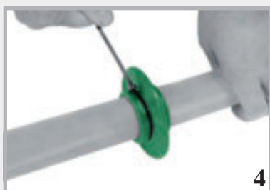
4 Festes Anziehen der beiden Spannbänder von Hand
