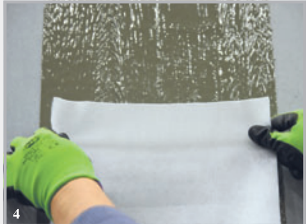
4 Das Vlies ausrichten und leicht andrücken.
