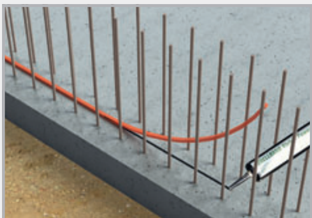
Quellbandkleber POWER aufspritzen und das Quellband FLOWSTOP in den Kleber einrollen.
