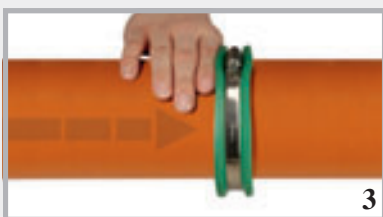
Mauerkragen positionieren, am besten Mitte Wand oder Sohle
