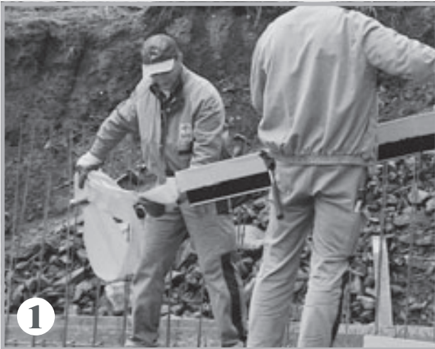
Entfernen der unteren Schutzfolie
