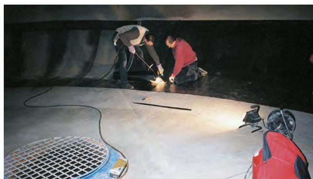
Innenabdichtung des Trinkwasserbehälters in einem Wasserturm
