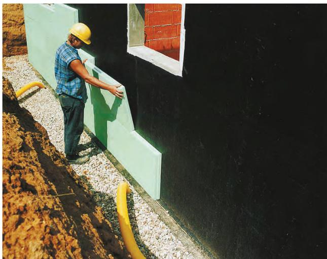
Schutzschicht mit Perimeterdämmung
