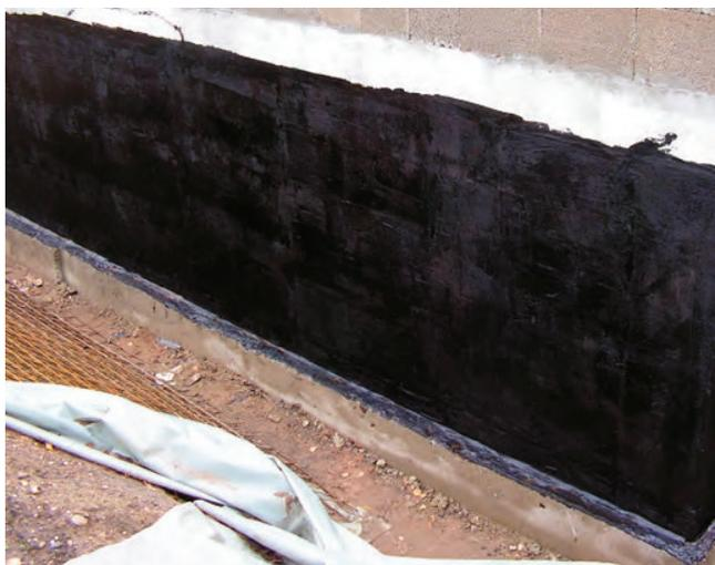
Elastomerbitumen-Voranstrich wird gut deckend aufgebracht
