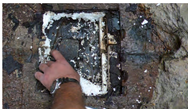
Bestandsaufnahme eines Daches für einen Sanierungsvorschlag
