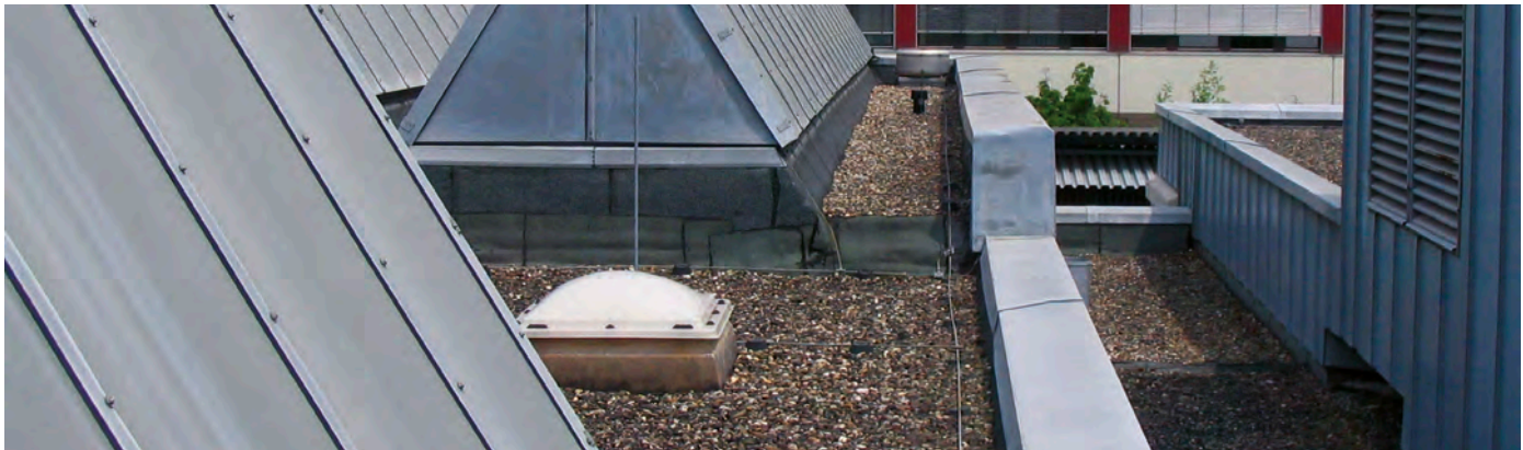
Flachdach mit erschwertem Zugang
