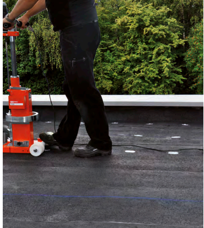
Zunächst wird das vorhandene Dachschichtenpaket mit mechanischen Befestigungselementen fixiert
