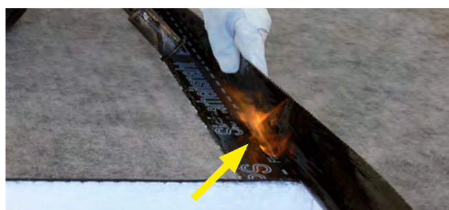
Flammschutz bei der Icopal-Sicherheitsdämmbahn
