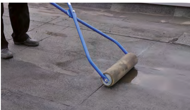
Wassersauger SCHLURF - saugt die Feuchtigkeit vom Dach auf
