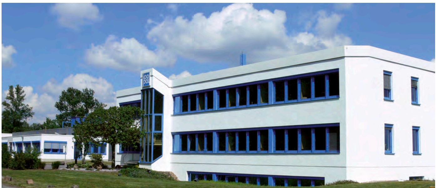
Icopal GmbH, Verwaltungsgebäude in Werne an der Lippe
