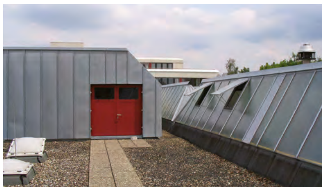
Flachdach mit Auflast
