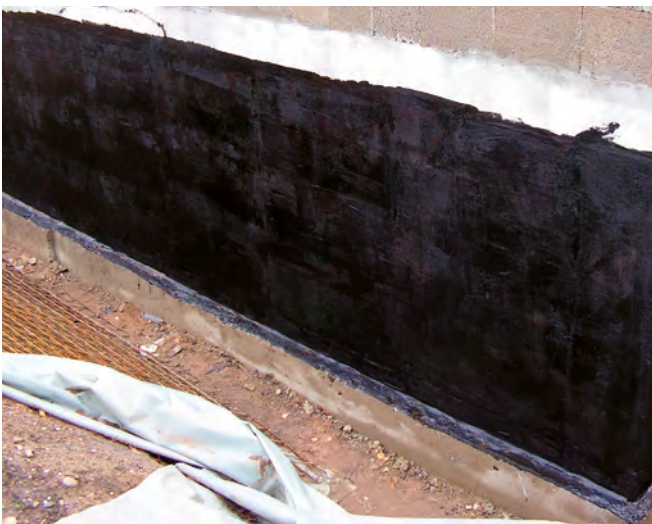
Elastomerbitumen-Voranstrich wird gut deckend aufgebracht
