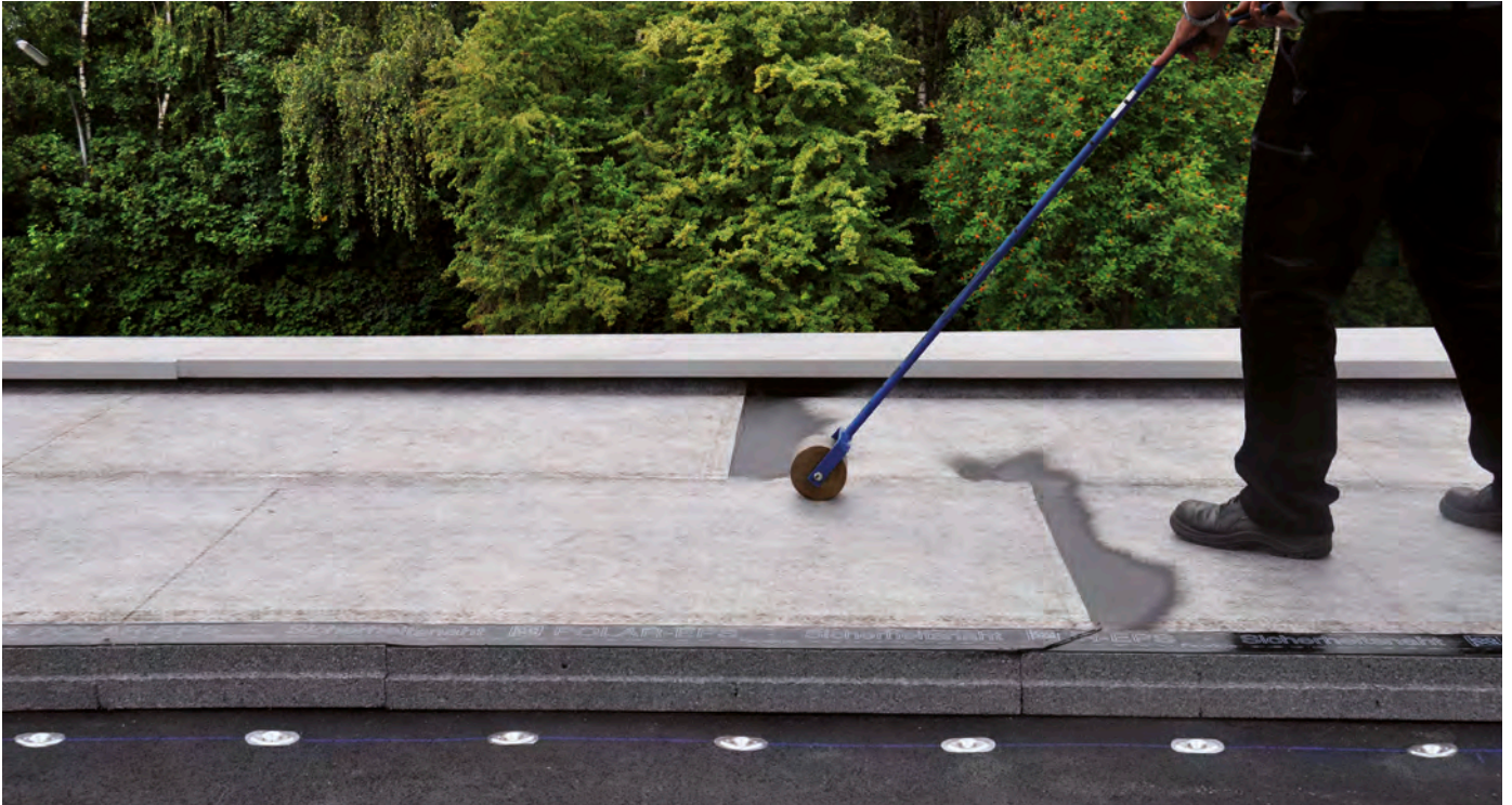
Nachdem die Sicherheitsdämmbahn verlegt ist, kann der Querstoßbereich der ersten Abdichtungslage mit einem Handbrenner geschlossen werden
