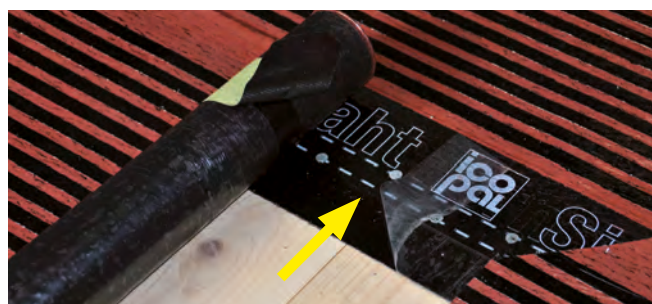
Flammschutz bei SICOTHERM
