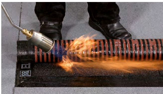
Icopal-Bahn mit bestreuungsfreiem Querstoß
