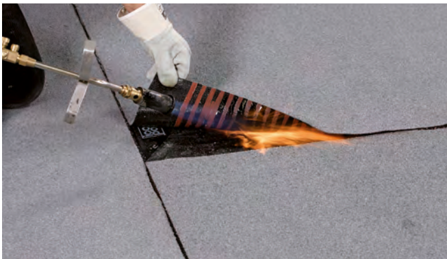
Handbrenner - Sicherheitsflammbeker mit windgeschützter Wachflamme
