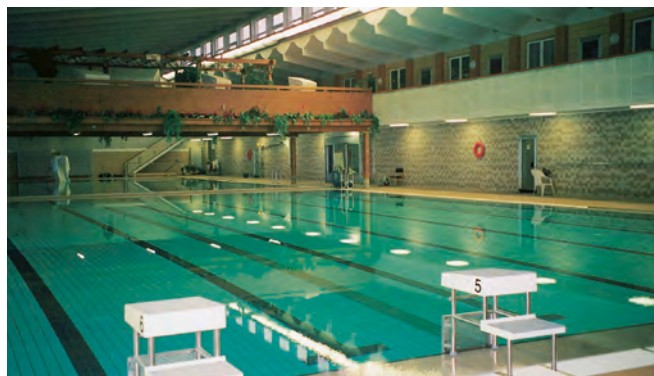
Inselbad in Eisenhüttenstadt (Hallenbad), zweilagige Abdichtung des Innenbeckens mit POLAR
