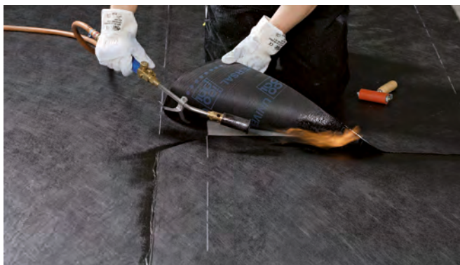
Nähte und Stöße müssen homogen verschweißt werden.
