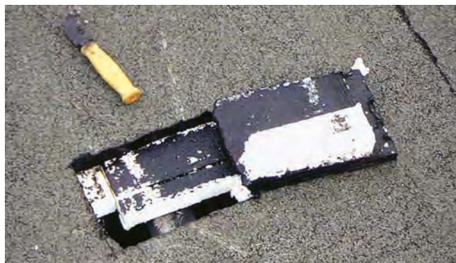
Dachöffnung zur Überprüfung des Schichtenaufbaus
