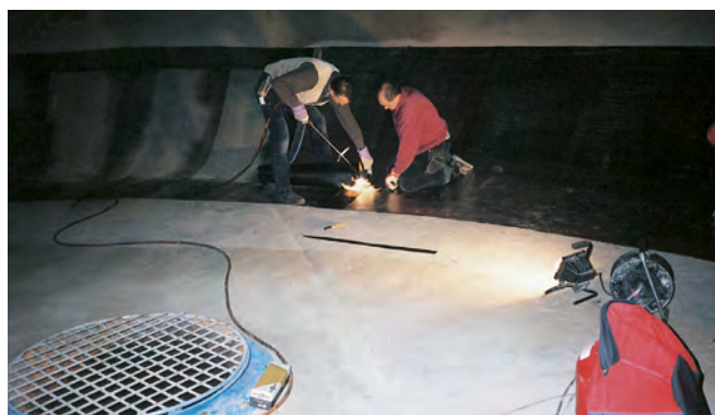
Innenabdichtung des Trinkwasserbehälters in einem Wasserturm
