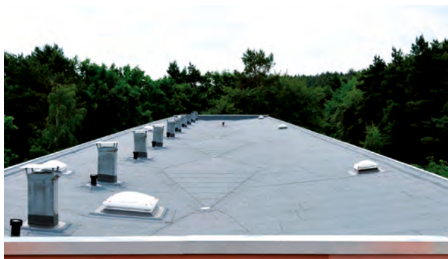
Flachdach mit frei bewitterter Dachabdichtung
