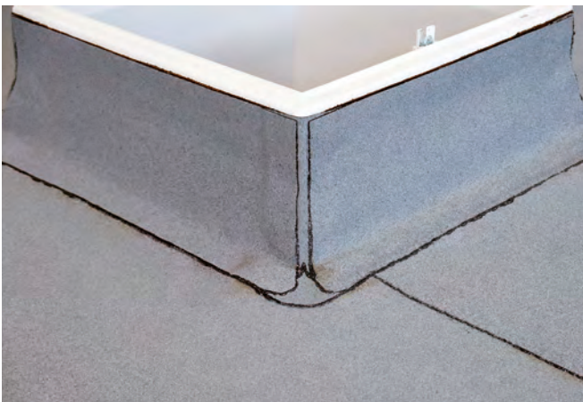
Verarbeitung der Anschlussbahnen
