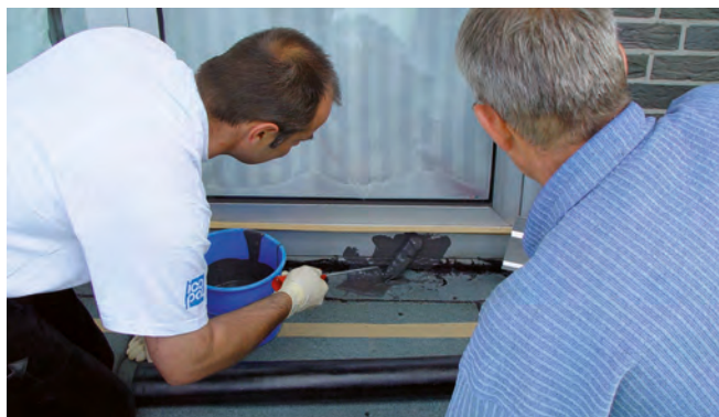
Einweisung an der Baustelle
