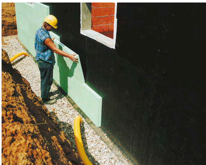
Schutzschicht mit Perimeterdämmung
