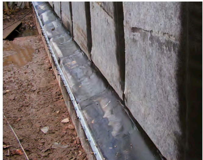
Eine zweilagige Abdichtung erhöht die Sicherheit
