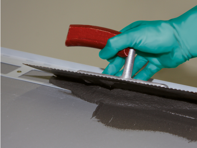
Offene Stege der Rinnenprofile werden mit Sopro megaFlex S2 turbo beigespachtelt.
