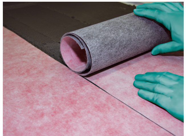
Die anschließende zweite Bahn wird stumpf stoßend an die erste Bahn verklebt.
