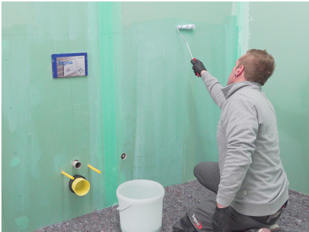
Saugende Untergründe mit Sopro Grundierung vorbehandeln.
