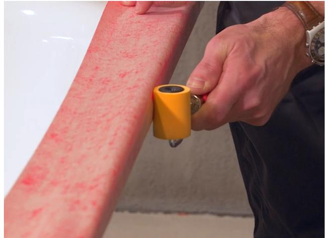
Nach dem Abziehen der Schutzfolie vom Klebestreifen das Sopro WannenDichtBand gerade an den Wannenrand ankleben. Mit Hilfe eines Rollers kann das Band im Anschluss fest angedrückt werden.
