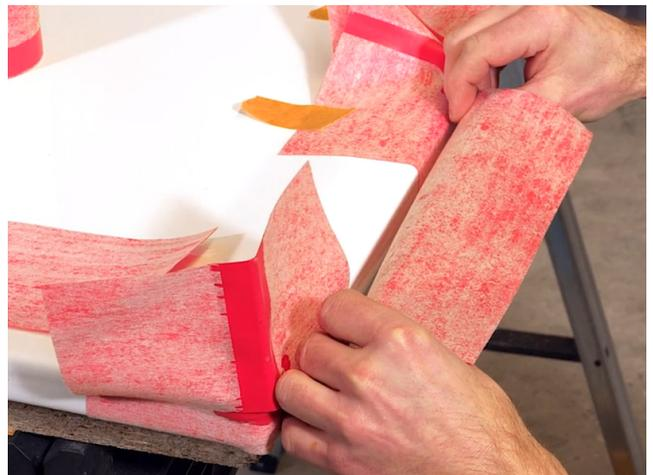
Das Sopro WannenDichtBand zurecht schneiden (Überlappung der Bänder und Formteile von mindestens 50 mm beachten). Die Bänder am Wannenrand gerade ankleben und mit einem Roller fest andrücken.
