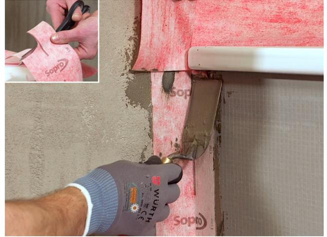
Senkrecht vom Boden kommendes Sopro AEB® Dichtband Flex (mit Falz) mit einer runden Aussparung am oberen Ende versehen. Dieses an der Wannendichtband- Verlängerung überlappend ansetzen und verkleben.
