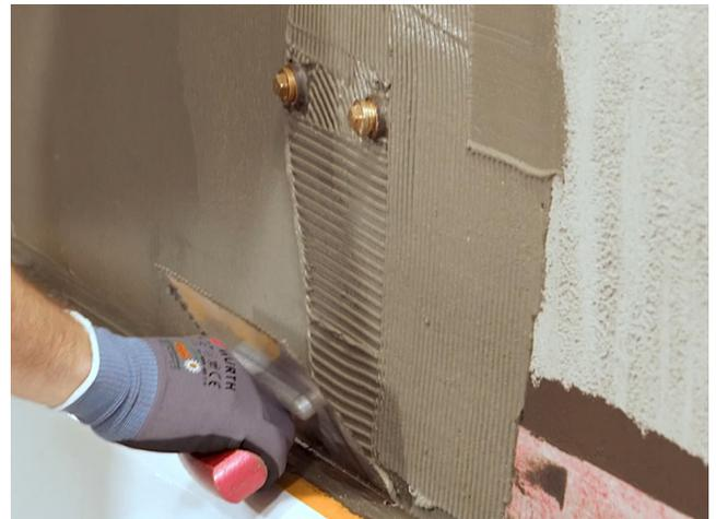
Vor dem Aufbringen jeder Lage Flächenabdichtung den Wannenrand mit Kreppband abkleben. Bänder und Formteile vollflächig überarbeiten. Vor Trocknung der jeweiligen Lage das Kreppband wieder entfernen.
