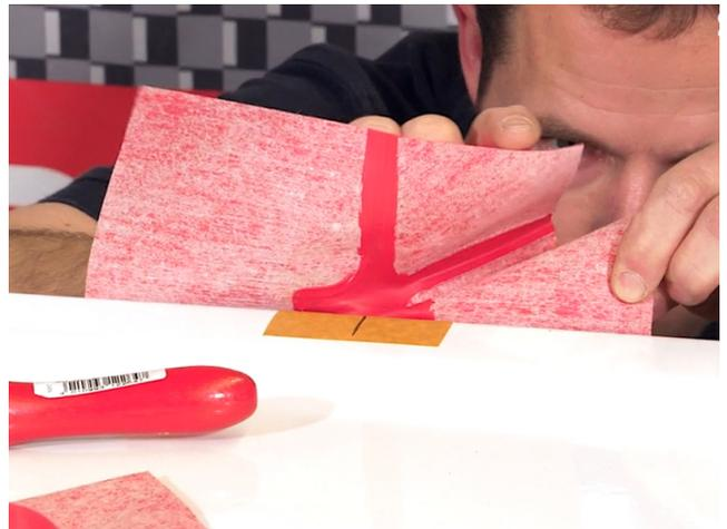
Die Sopro WannenDichtMultiecke am Wannenrand in Höhe der zuvor angebrachten Markierung ausrichten, ankleben und festdrücken. Das hochflexible Formteil ist für viele verschiedene Einbausituationen geeignet.
