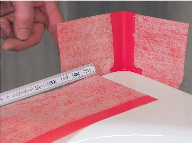
Das Sopro WannenDichtBand wird auf die Abmessungen der Badewanne zurecht geschnitten. Eine Überlappung der Bänder und Formteile von mindestens 50 mm ist mit einzuberechnen.
