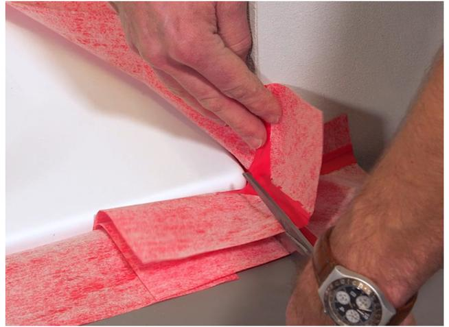
Die beiden übereinander geklebten Multiecken werden eingeschnitten, um diese miteinander eindichten zu können: Die oben liegende Multiecke auf der linken Seite einschneiden, die unten liegende auf der rechten Seite.
