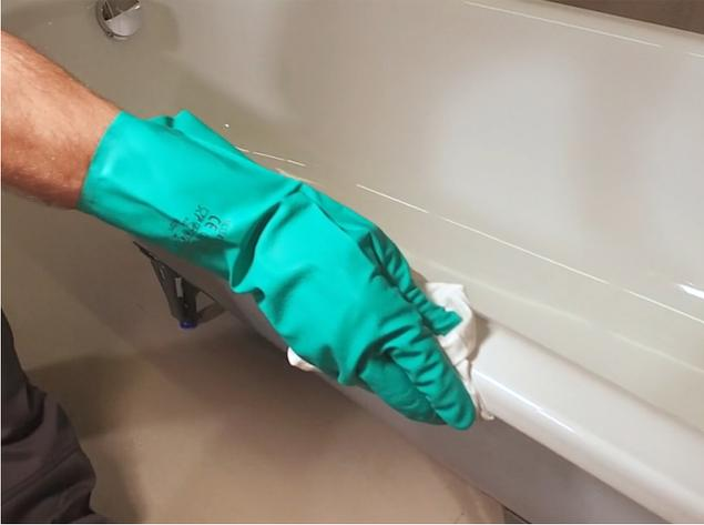
Wannenrand mit einem geeigneten Reiniger von Verunreinigungen, Fetten und haftungsmindernden Substanzen befreien. Danach ablüften lassen. Die Reiniger dürfen keinen trennend wirkenden Film hinterlassen!
