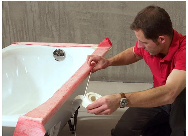
Bänder und Formteile mit Kreppband provisorisch an der Wanne fixieren. Dann den selbstklebenden Sopro WannenDichtSchallschutz ankleben und festdrücken. Wanne danach an der Wand ausrichten und anschließen.
