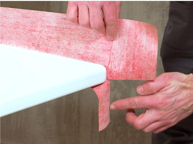
Das Sopro WannenDichtBand ist am Wannenende durch das Ankleben eines um 90° gedrehten, ca. 14 – 16 cm langen, Streifens über den Wannenrand hinaus zu verlängern. Verlängerung im Anschluss einschneiden.
