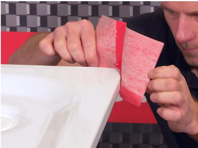
Nach dem Abziehen der Schutzfolie vom Klebestreifen die Sopro WannenDichtEcke am Wannenrand ausrichten, ankleben und festdrücken. Das hochflexible Formteil ist für alle gängigen Wannenradien geeignet.
