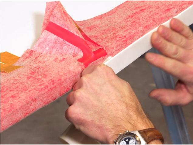
Bänder und Formteile mit Kreppband provisorisch an der Wanne fixieren. Dann den selbstklebenden Sopro WannenDichtSchallschutz ankleben und festdrücken. Duschwanne danach einsetzen und anschließen.
