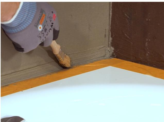
Alle Übergänge der Bänder und Formteile zur Wanne mit einem Pinsel sorgfältig überarbeiten. Bei Bedarf im Bereich von Anschluss und Bewegungsfugen das Sopro SchnittSchutzBand einbetten.
