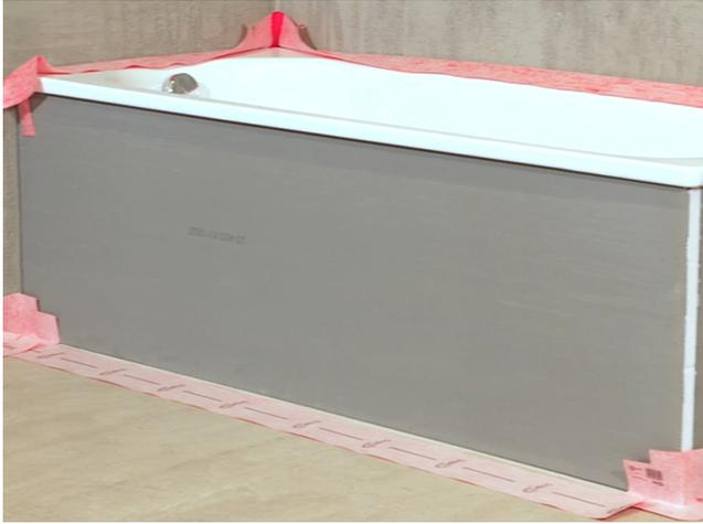
Im Bereich vor und über der Wanne sind Sopro AEB® Dichtband Flex (mit Falz) sowie AEB® Dichtecken zu verwenden. Alle waagerechten und senkrechten Bänder auf die richtige Länge zurecht schneiden (mind. 50 mm Überlappung)
