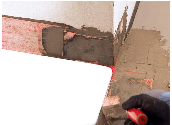
Alle Überlappungen werden wasserdicht miteinander verklebt. Beim Aufbringen der Flächenabdichtung alle Bänder und Formteile vollflächig überarbeiten. Übergänge zur Wanne sorgfältig mit einem Pinsel überarbeiten
