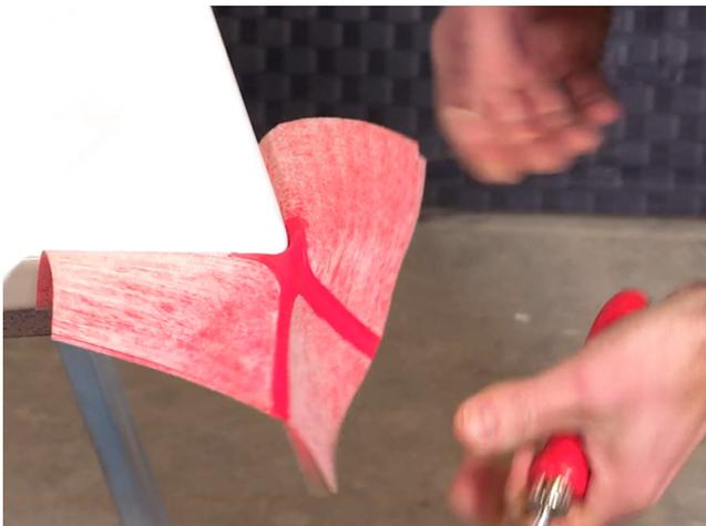
Treffen Duschwanne und Wand in einer Flucht aufeinander, werden zwei Multiecken an gleicher Stelle übereinander geklebt. Mit Hilfe eines Rollers können die Multiecken fest angedrückt werden.
