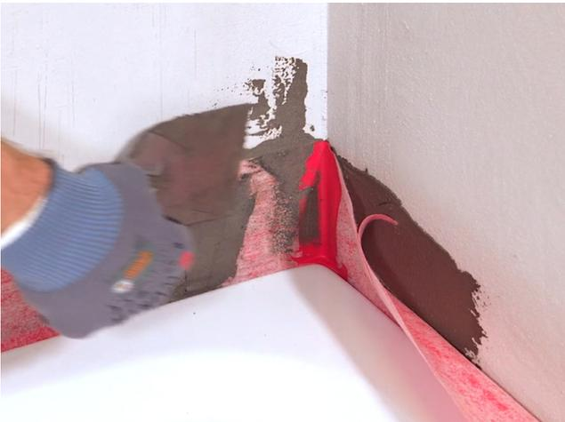
Bänder und Formteile in eine Schicht aus im System geprüften Stoß- und Überlappungskleber vollflächig einlegen. Mit Kelle oder Farbrollen- Bügel alle Teile fest andrücken.
