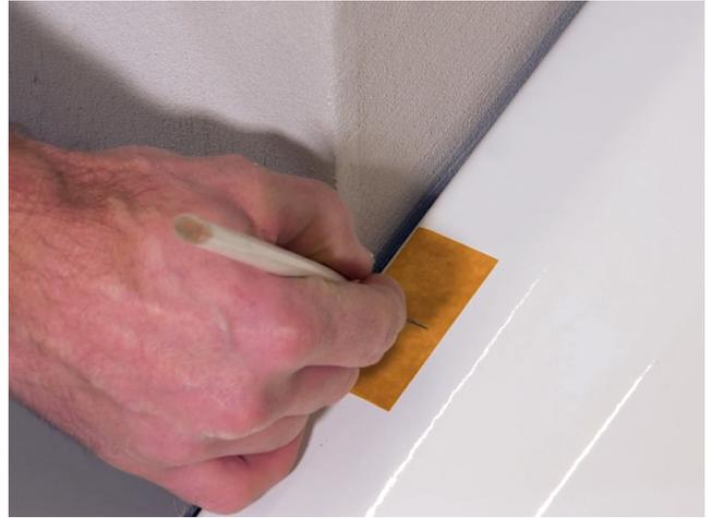
Zu Beginn die Duschwanne in die spätere Position einsetzen. Markierungen für die Formteile am Duschwannenrand, je nach Raumgeometrie, mit Hilfe von Kreppband und Bleistift anbringen.
