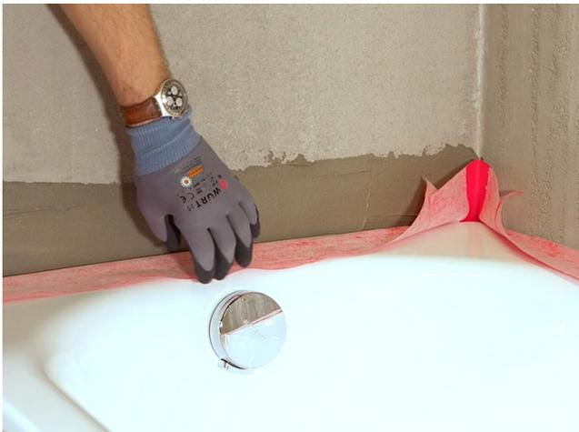
Bänder und Formteile in eine Schicht aus im System geprüften Stoß- und Überlappungskleber vollflächig einlegen. Alle Überlappungen wasserdicht verkleben. Mit Kelle oder Farbrollen-Bügel alle Teile fest andrücken.
