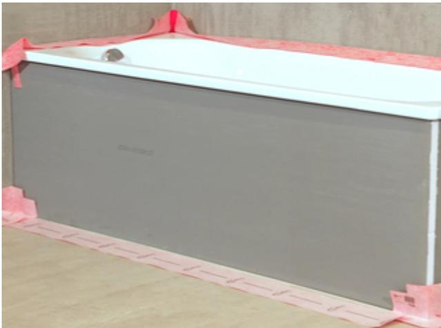
7) Im Bereich vor und über der Wanne sind Sopro AEB® Dichtband Flex (mit Falz) sowie AEB® Dichtecken zu verwenden. Alle waagerechten und senkrechten Bänder auf die richtige Länge zurecht schneiden (mind. 50 mm Überlappung)
