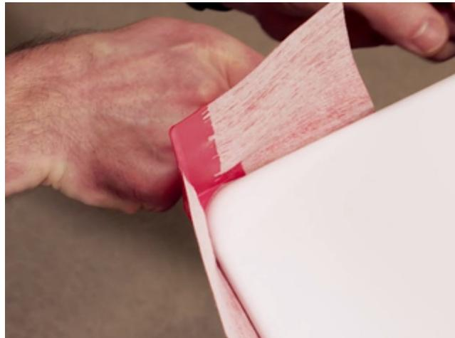
2) Nach dem Abziehen der Schutzfolie vom Klebestreifen die Sopro WannenDichtEcke am Wannenrand ausrichten, ankleben und festdrücken. Das hochflexible Formteil ist für alle gängigen Wannenradien geeignet.
