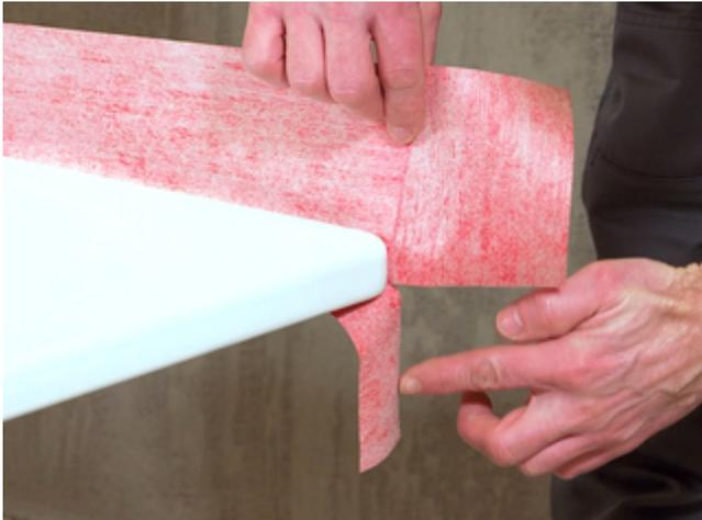
5) Das Sopro WannenDichtBand ist am Wanneneende durch das Ankleben eines um 90° gedrehten, ca. 14 - 16 cm langen, Streifens über den Wannenrand hinaus zu verlängern. Verlängerung im Anschluss einschneiden.
