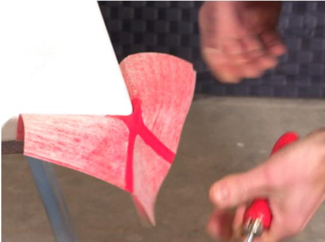
5) Treffen Duschwanne und Wand in einer Flucht aufeinander, werden zwei Multiecken an gleicher Stelle übereinander geklebt. Mit Hilfe eines Rollers können die Multiecken fest angedrückt werden.
