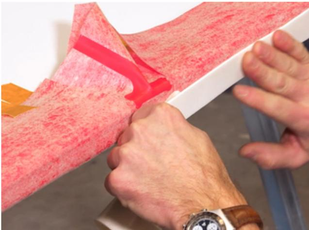
7) Bänder und Formteile mit Kreppband provisorisch an der Wanne fixieren. Dann den selbstklebenden Sopro WannenDichtSchallschutz ankleben und festdrücken. Duschwanne danach einsetzen und anschließen.
