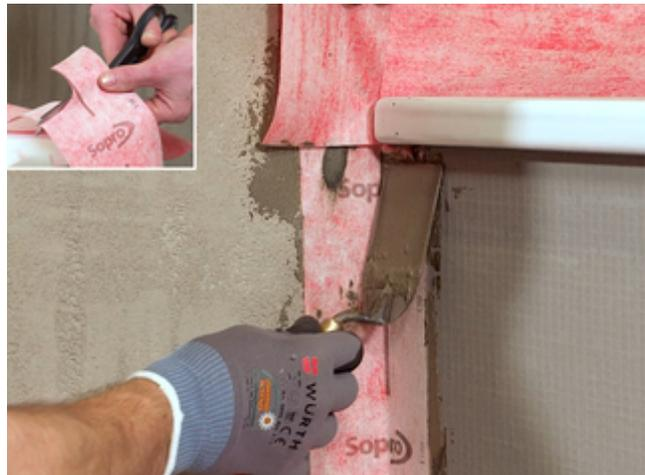
8) Senkrecht vom Boden kommendes Sopro AEB® Dichtband Flex (mit Falz) mit einer runden Aussparung am oberen Ende versehen. Dieses an der Wannendichtband-Verlängerung überlappend ansetzen und verkleben.
