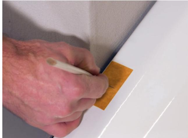
2) Zu Beginn die Duschwanne in die spätere Position einsetzen. Markierungen für die Formteile am Duschwannenrand, je nach Raumgeometrie, mit Hilfe von Kreppband und Bleistift anbringen.
