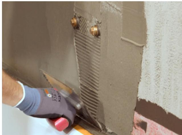
10) Vor dem Aufbringen jeder Lage Flächenabdichtung den Wannenrand mit Kreppband abkleben. Bänder und Formteile vollflächig überarbeiten. Vor Trocknung der jeweiligen Lage das Kreppband wieder entfernen.
