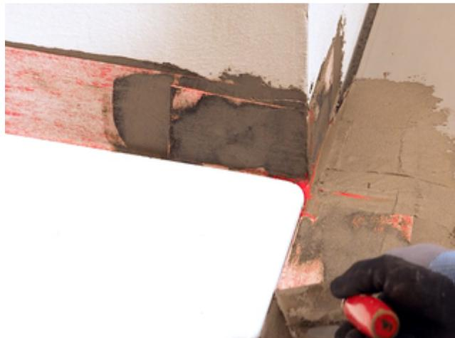
10) Alle Überlappungen werden wasserdicht miteinander verklebt. Beim Aufbringen der Flächenabdichtung alle Bänder und Formteile vollflächig überarbeiten. Übergänge zur Wanne sorgfältig mit einem Pinsel überarbeiten
