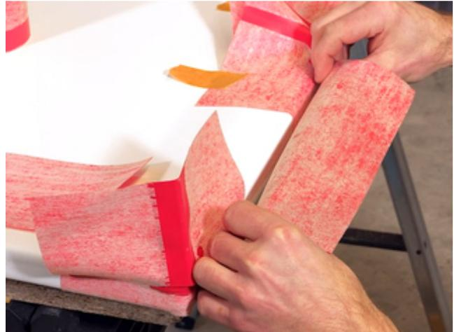
6) Das Sopro WannenDichtBand zurecht schneiden (Überlappung der Bänder und Formteile von mindestens 50 mm beachten). Die Bänder am Wannenrand gerade ankleben und mit einem Roller fest andrücken.
