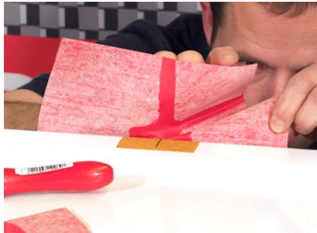
4) Die Sopro WannenDichtMultiecke am Wannenrand in Höhe der zuvor angebrachten Markierung ausrichten, ankleben und festdrücken. Das hochflexible Formteil ist für viele verschiedene Einbausituationen geeignet.
