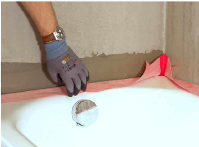
9) Bänder und Formteile in eine Schicht aus im System geprüften Stoß- und Überlappungskleber vollflächig einlegen. Alle Überlappungen wasserdicht verkleben. Mit Kelle oder Farbrollen-Bügel alle Teile fest andrücken.
