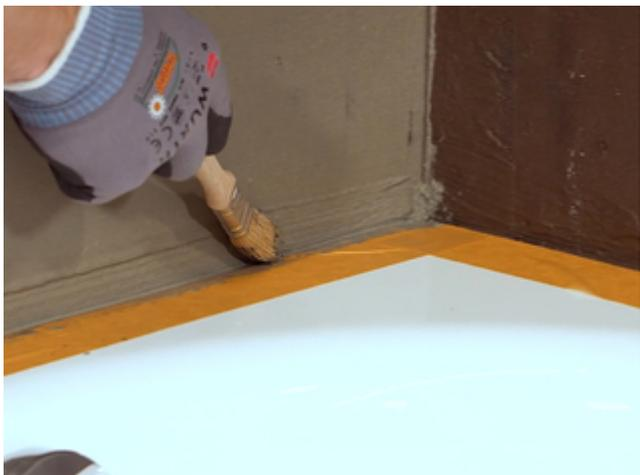
11) Alle Übergänge der Bänder und Formteile zur Wanne mit einem Pinsel sorgfältig überarbeiten. Bei Bedarf im Bereich von Anschluss und Bewegungsfugen das Sopro SchnittSchutzBand einbetten.
