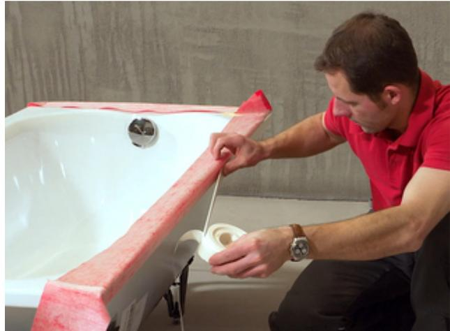
6) Bänder und Formteile mit Kreppband provisorisch an der Wanne fixieren. Dann den selbstklebenden Sopro WannenDichtSchallschutz ankleben und festdrücken. Wanne danach an der Wand ausrichten und anschließen.
