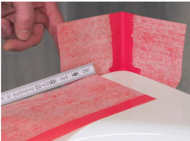
3) Das Sopro WannenDichtBand wird auf die Abmessungen der Badewanne zurecht geschnitten. Eine Überlappung der Bänder und Formteile von mindestens 50 mm ist mit einzuberechnen.
