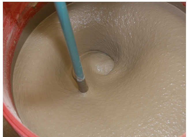
Der selbstnivellierende Sopro FaserFließSpachtel ist mit einem Rührquirl zu einer homogenen, klumpenfreien Masse anzurühren ...
