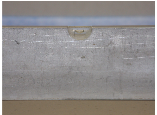
Der Sopro FaserFließSpachtel ist nach seiner Erhärtung ebenmäßig und verlegebereit.
