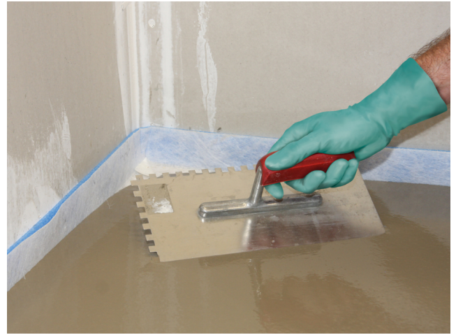
Mit einer Glättkelle oder einem Raket kann der Sopro FaserFließSpachtel gleichmäßig verteilt werden.
