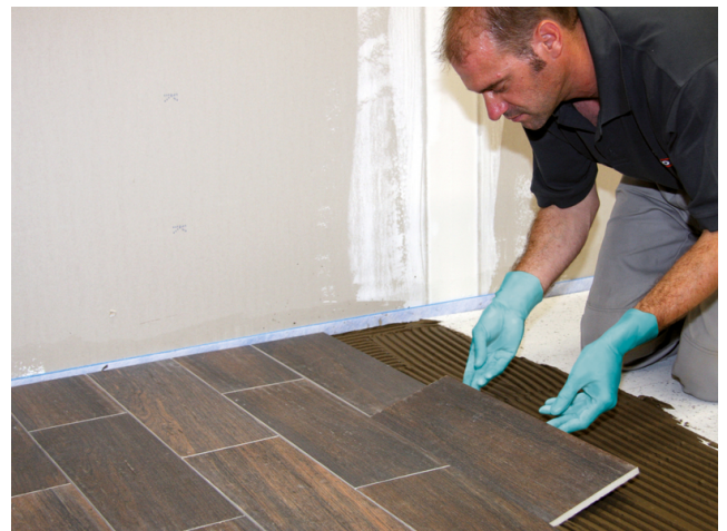
Aufziehen eines Sopro Flexklebers (z. B. Sopro's No. 1) und anschließendes Einlegen der Fliesen.
