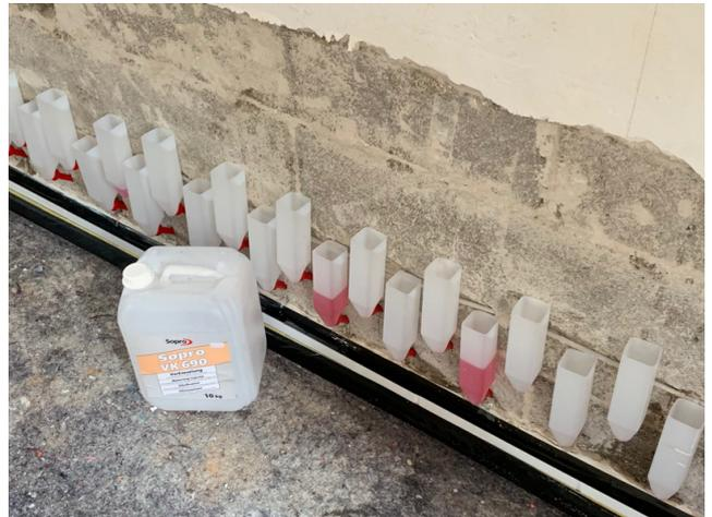
Bohrlöcher staubfrei machen und solange Sopro Verkieselung in die gesetzten Trichter einfüllen, bis keine Flüssigkeit mehr aufgenommen wird.
