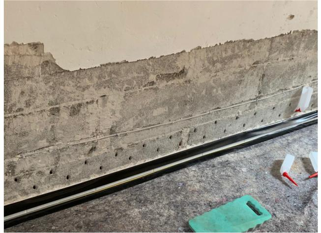
Über Oberkante Erdreich (Wand-Boden-Ansatz) die Bohrungen in einem Abstand von 8 – 10 cm, höhenversetzt im Zickzackmuster, anordnen.
