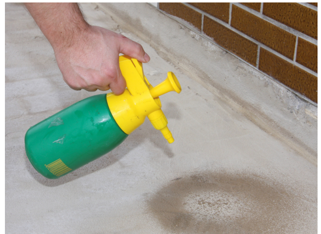
Vornässen des Untergrundes im Außenbereich für den nachfolgenden Auftrag der Sopro TurboDichtSchlämme 2-K. Untergründe im Innenbereich sind mit Sopro Grundierung vorzubehandeln.
