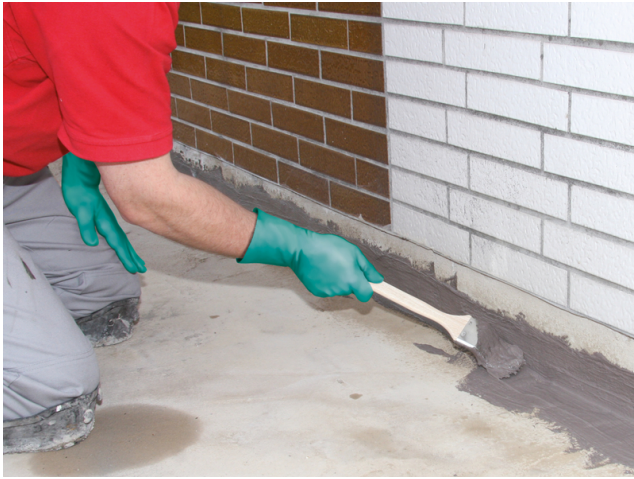
Einstreichen des Sockelbereiches mit Sopro TurboDichtSchlämme 2-K zur Fixierung ...
