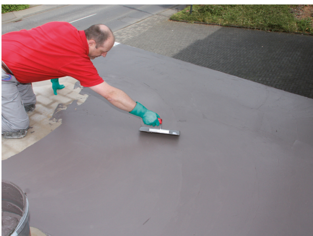
Glätten der Sopro TurboDichtSchlämme 2-K mittels Glättkelle.
