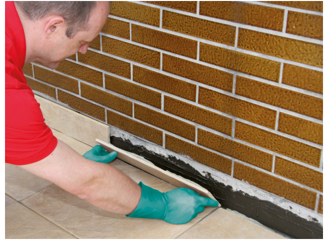
... und Ansetzen der Sockelfliese.
