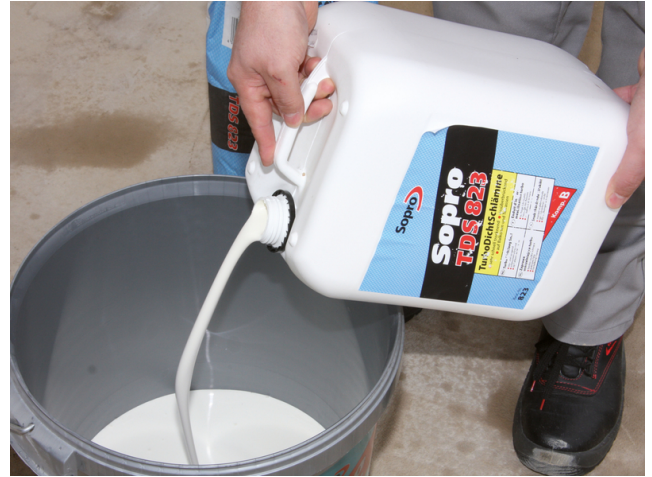
Vorgeben der Nasskomponente der Sopro TurboDichtSchlämme 2-K in einen sauberen Eimer.
