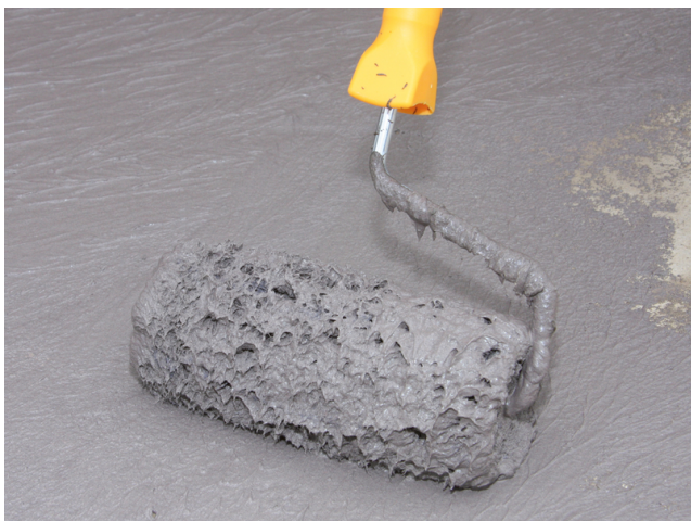
Die Verarbeitung der Sopro TurboDichtSchlämme 2-K kann auch mit einer Lammfellrolle erfolgen.
