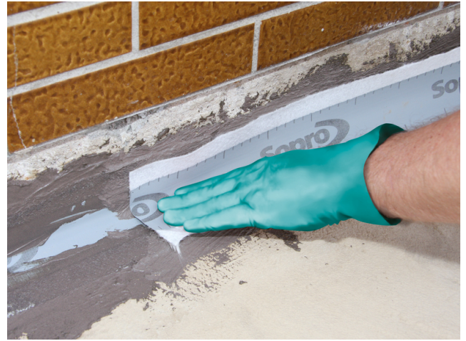
... des anschließend eingelegten Sopro Dichtbandes. Dieses ist zusätzlich einzudrücken.
