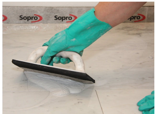
Einfugen von Sopro DF 10 in verarbeitungsempfindlichen Naturstein.
