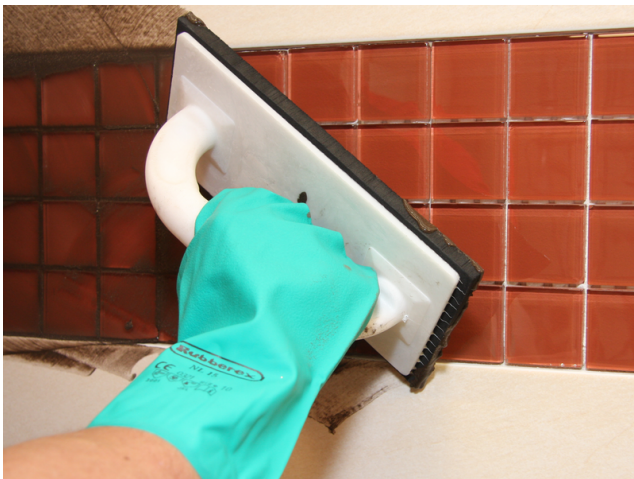
Einfugen von Sopro DF 10 in Glasmosaik.
