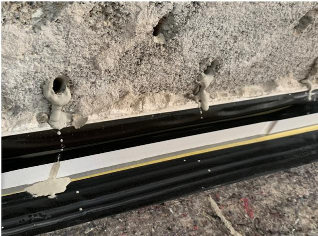
Zerklüftungen bzw. offene Fugen müssen vor der Injektage von Sopro Verkieselung mit Sopro BohrLochSchlämme verfüllt werden.
