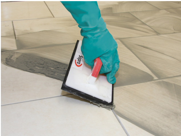
Einfügen der Sopro Fugenmasse (z. B. Sopro DF 10® DesignFuge Flex, Sopro Brillant® PerlFuge).
