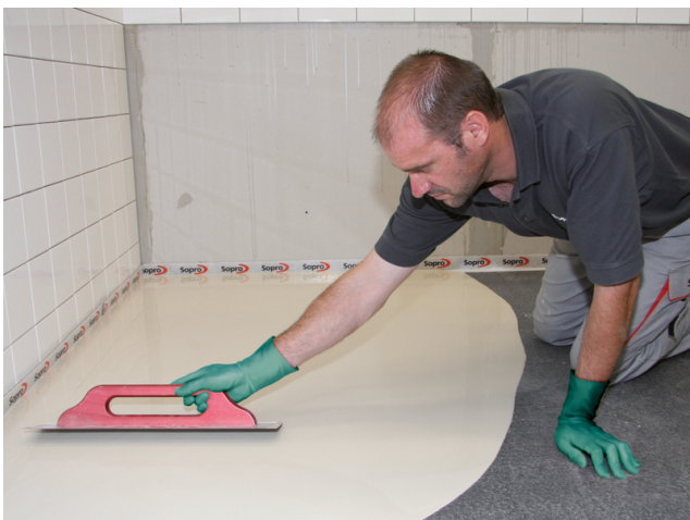
Mittels Glättkelle oder Rakel ist Sopro FS Hybrid bis zur erforderlichen Schichtdicke zu verteilen.
