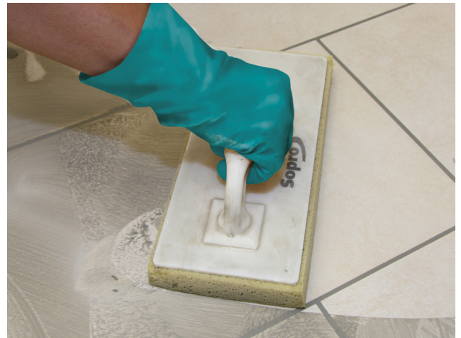
Abwaschen der Sopro Fugenmasse.
