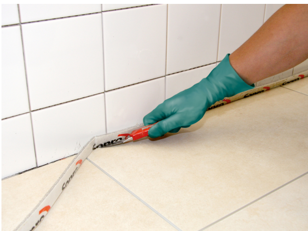
Abschneiden des Sopro RandDämmStreifens mit einem Cutter-Messer.
