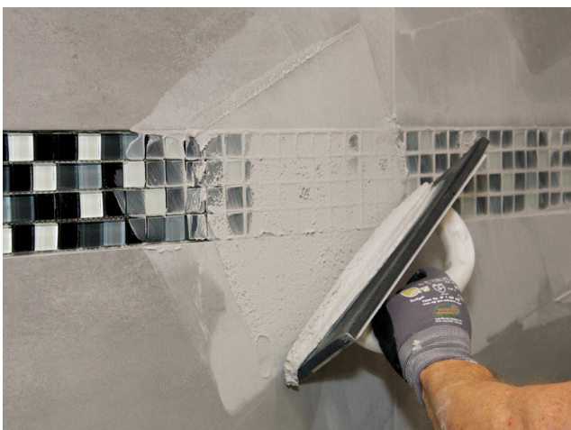
Verfugen mit Sopro DF 10® DesignFuge Flex im Farbton silbergrau.
