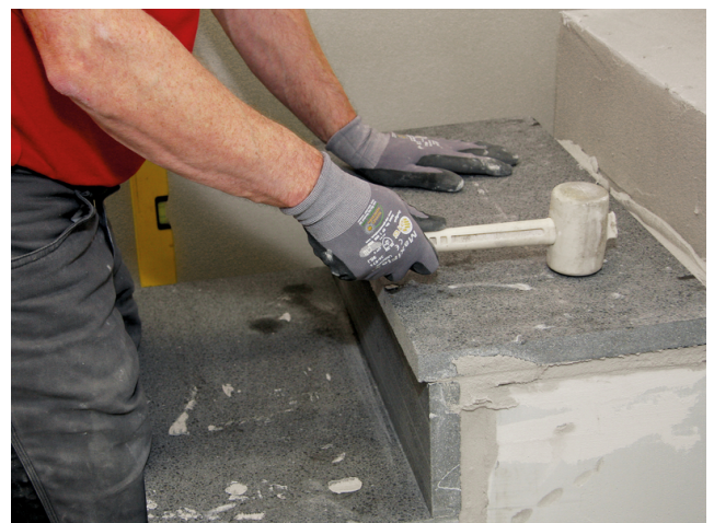
Verlegen einer Treppenstufe. Aufgrund der Schnellerhärtung kann eine frühe Belastung erfolgen.
