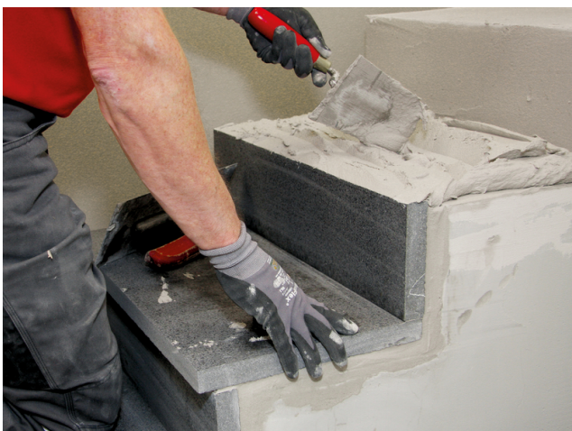
Sopro FKM® Silver kann auch in höheren Schichtstärken bis 20 mm verarbeitet werden.
