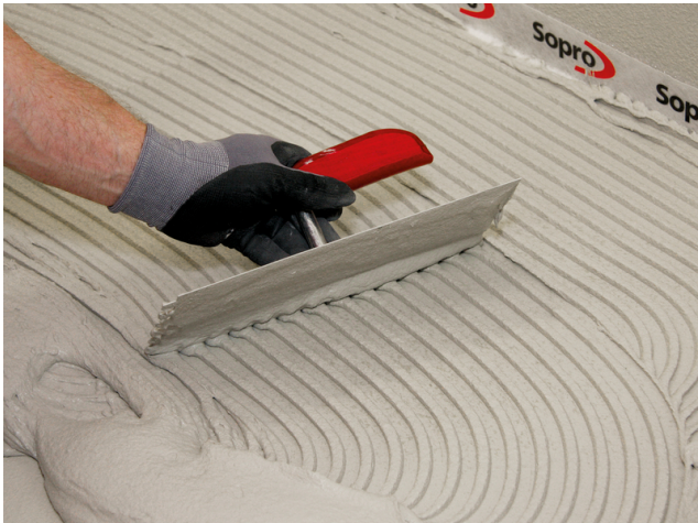
Aufziehen der Kontaktschicht und des Kammbetts in der Fließbettkonsistenz.
