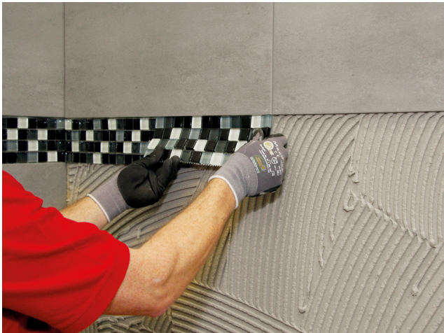
Einlegen von Glasmosaik in das vorbereitete Kleberbett.
