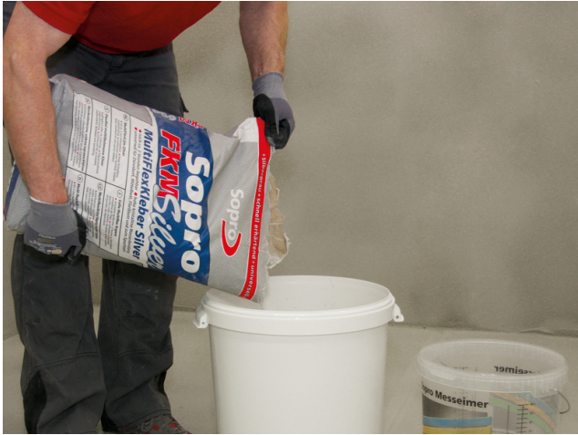
Anrühren von Sopro FKM® Silver in der gewünschten Konsistenz für die Verlegung im Dünn-, Fließ- oder Mittelbett bzw. zum Spachteln.
