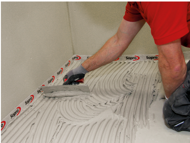
Zur Mittelbettverlegung Sopro FKM® Silver in der Mittelbettkonsistenz aufziehen.
