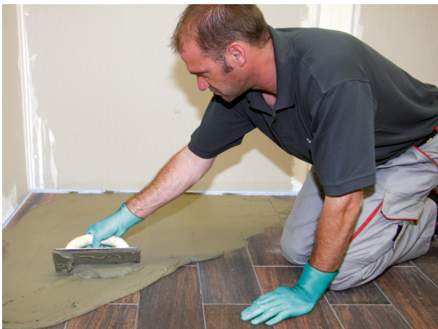
Verfugen der Fläche mit z. B. Sopro DF 10® DesignFuge Flex.
