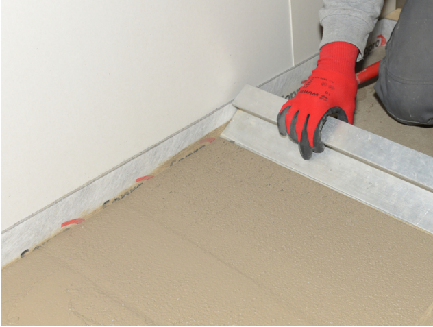
Herstellen eines Gefälles durch Abziehen mit der Latte.
