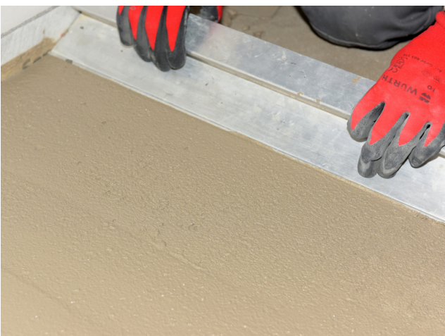
Selbstheilungseffekt durch selbstständiges Verdichten des Materials.
