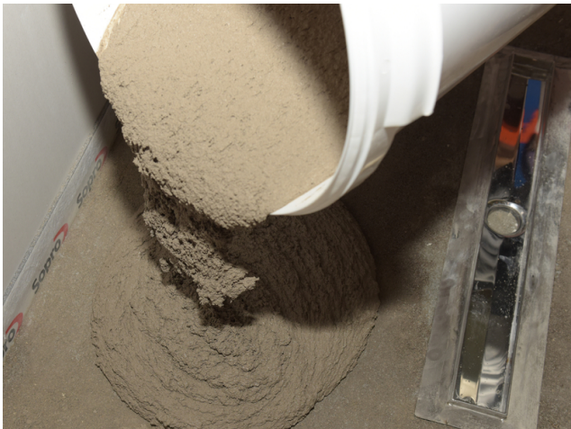
Ausgießen des VS 582 in standfester Konsistenz als Gefällespachtel bei mittlerer Wasserzugabe (3,75 l).
