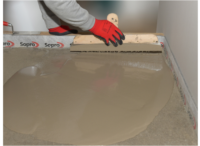
Leichtgängiges Verteilen der Fließspachtelmasse. Unmittelbar anschließendes Entlüften mit einer Stachelwalze ist erforderlich.
