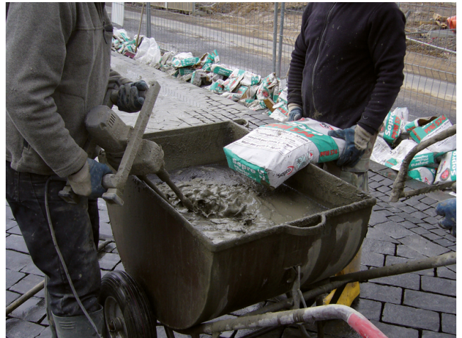
Alternativ: Anmischen des Fugenmörtels mittels Rührgerät.
