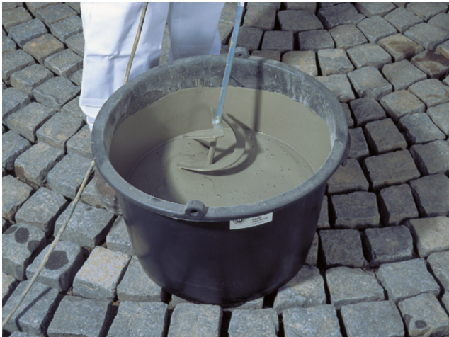
Anmischen von Sopro PflasterFugMörtel hochfest mit Wendelkorbrührer.
