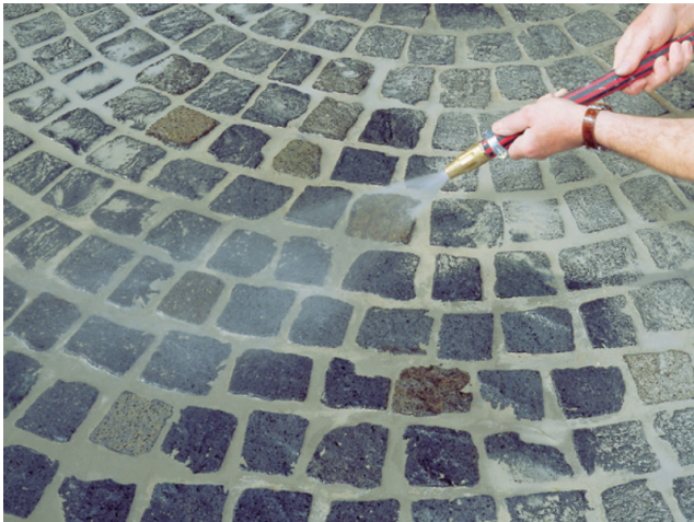
Absprühen mit feinem Wasserstrahl nach Erstarrungsbeginn des Fugenmörtels
