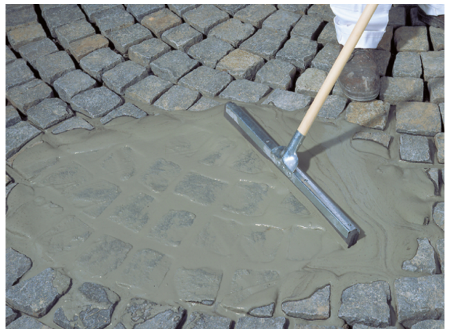
Fugenfüllendes Einschlämmen von Sopro PflasterFugMörtel hochfest.
