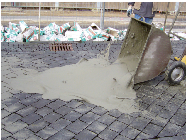
Leichtes Verfüllen der Fugen aufgrund hervorragender Verlaufseigenschaften des Fugenmörtels.
