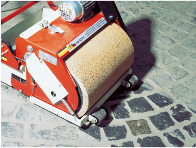
Abwaschen des Belags mit Reinigungsmaschine ...
