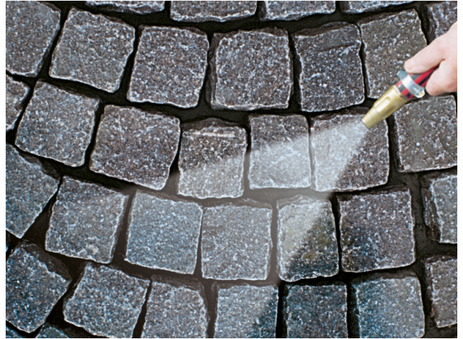
Vornässen des gereinigten, zu verfügenden Belags.
