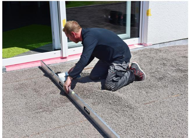
Die Fläche wird mittels eines Richtscheits gleichmäßig eben mit einer Bettungsdicke von 30 – 50 mm abgezogen, mittels Glättkelle nachgearbeitet und für die Verlegung vorbereitet.
