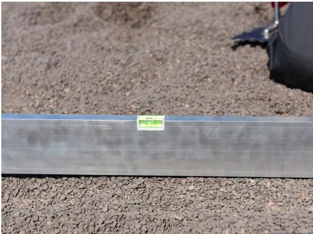
Die Höhe der Tragschicht und die Ausbildung eines Gefälles von mind. 1,5 % sind stets zu kontrollieren.
