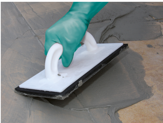
Einfügen einer Sopro Fugenmassen (z. B. Sopro DF 10® Design- Fuge Flex oder Sopro FlexFuge FL) nach Erhärtung des Sopro Flexklebers
