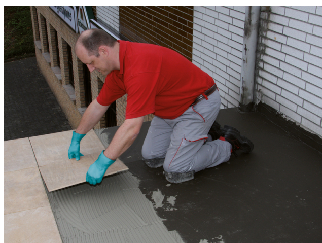
Einlegen und Einschieben der Platten in das frische Kleberbett.
