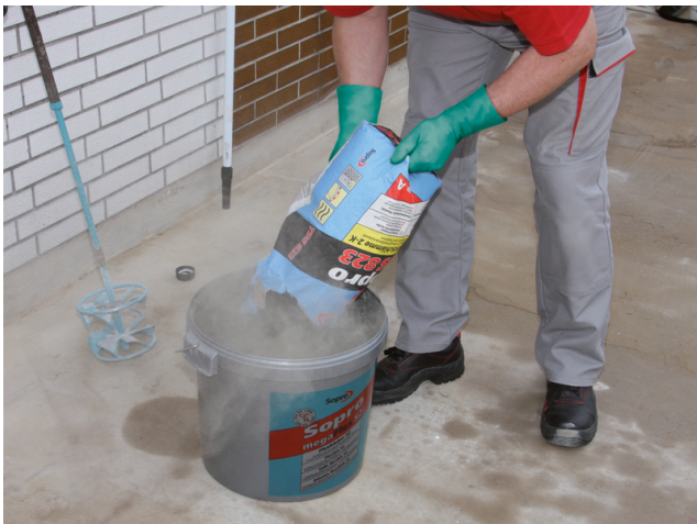
Hinzugeben der Trockenkomponente der Sopro TurboDichtSchlämme 2-K.
