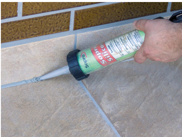
Einbringen des Sopro SanitärSilikons in die Anschluss- und Bewegungsfugen.
