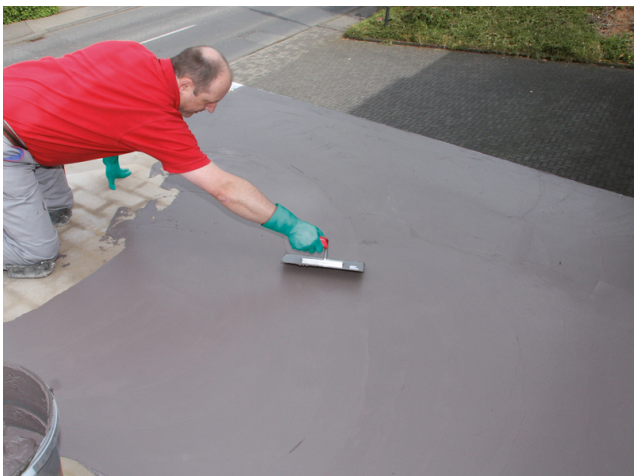
Glätten der Sopro TurboDichtSchlämme 2-K mittels Glättkelle.
