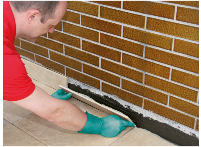
... und Ansetzen der Sockelfliese.
