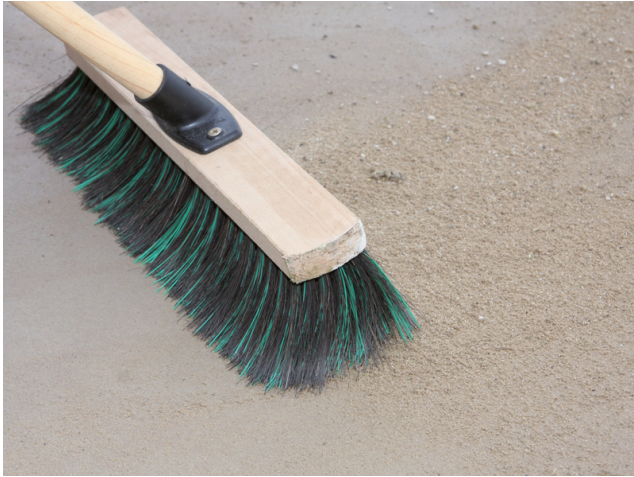
Säubern des vorbereiteten, ebenmäßigen Untergrundes.
