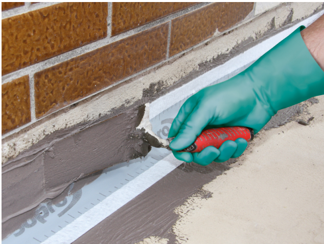
Überarbeiten des Sopro Dichtbandes mit Sopro TurboDichtSchlämme 2-K.
