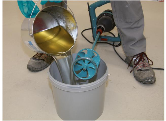
... der Sopro Epoxi-Grundierung restlos in den Behälter der Komp. A geben, homogen vermischen, anschließend in ein sauberes Gefäß umfüllen und erneut umrühren.
