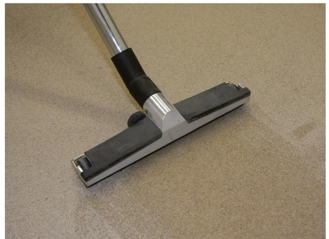
Überschüssigen Quarzsand nach vollständiger Trocknung der Sopro Epoxi-Grundierung (nach ca. 24 Stunden) bzw. des Sopro MultiGrundes (nach 30 – 40 Minuten) mit einem Industriesauger oder einem Besen aufnehmen.
