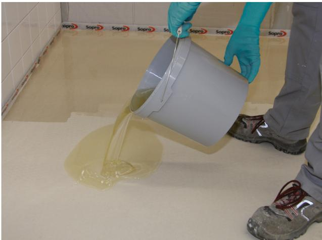
Nach Erreichen der Begehbarkeit und Prüfung der Restfeuchte die Sopro Epoxi-Grundierung bzw. Sopro MultiGrund auf den Untergrund ausgießen ...
