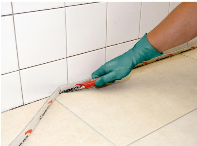
Abschneiden des Sopro RandDämmStreifens mit einem Cutter-Messer.
