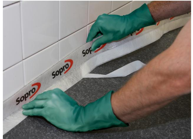
Anbringen des selbstklebenden Sopro RandDämmStreifens nach Trocknung des Sopro HaftPrimer S (1 – 2 Stunden).
