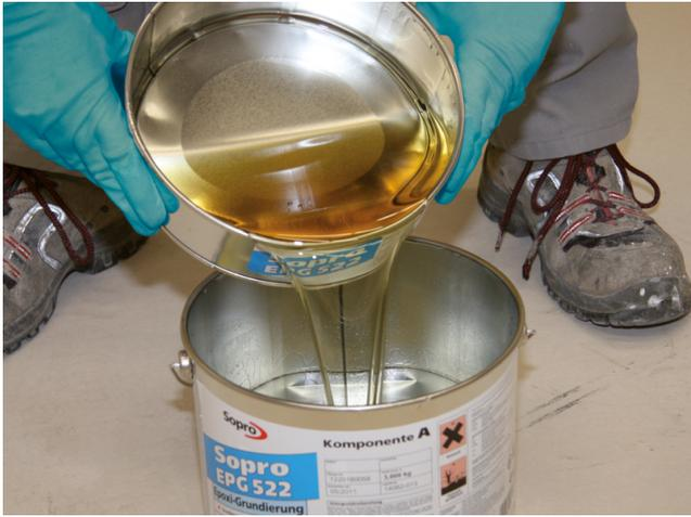
Um eine Rückdurchfeuchtung der Estrichkonstruktion zu verhindern, ist die Fläche mit Sopro Epoxi-Grundierung bzw. Sopro MultiGrund zu grundieren. Dazu Komp. B ...
