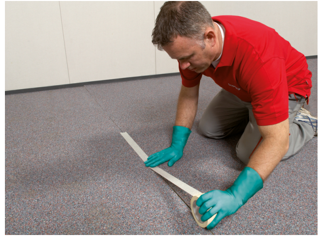
Zur Vermeidung von Mörtelbrücken (Körperschallbrücken) können die Stöße der Bahnen mit Kleband überklebt werden.
