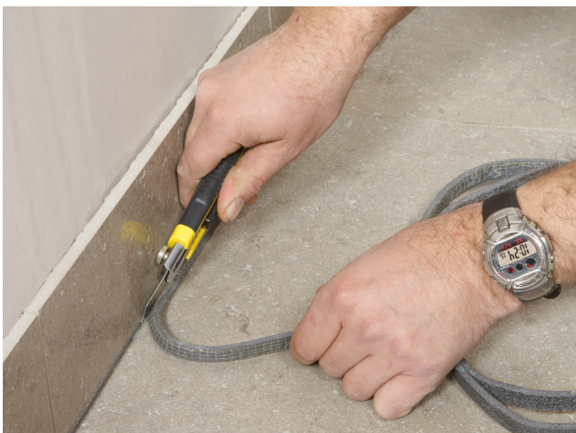
... um ihn im nächsten Arbeitsschritt mit einem Trapezmesser abschneiden zu können.
