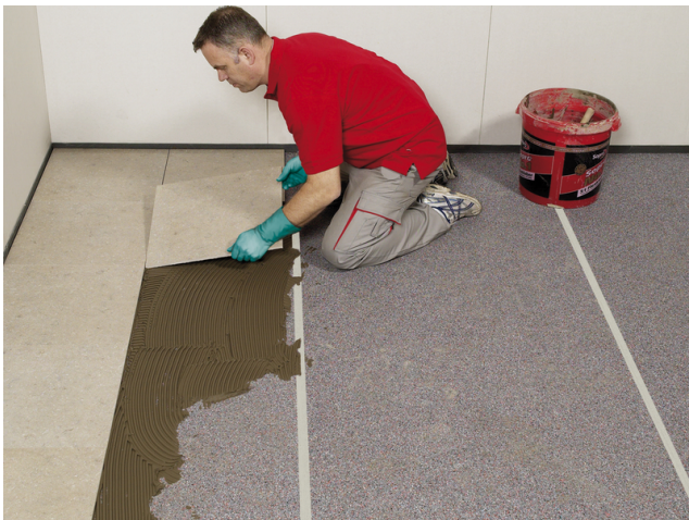
Nach Erhärtung des Verlegemörtels kann die Fliesenverlegung z. B. mit Sopro's No. 1 schnell direkt auf der Bahn erfolgen.
