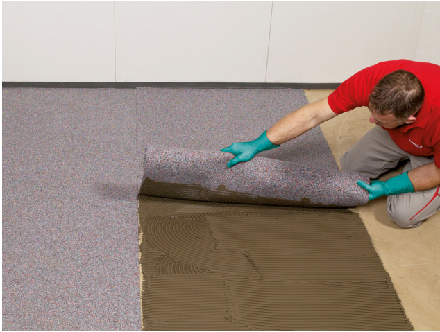
Die nachfolgende Bahn dicht anlegen und stoßen. Dabei darauf achten, dass kein Verlegemörtel durch den Stoßbereich austritt.
