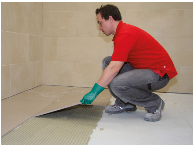
Großformatiges Feinsteinzeug einlegen und ausrichten. Fugennetz
