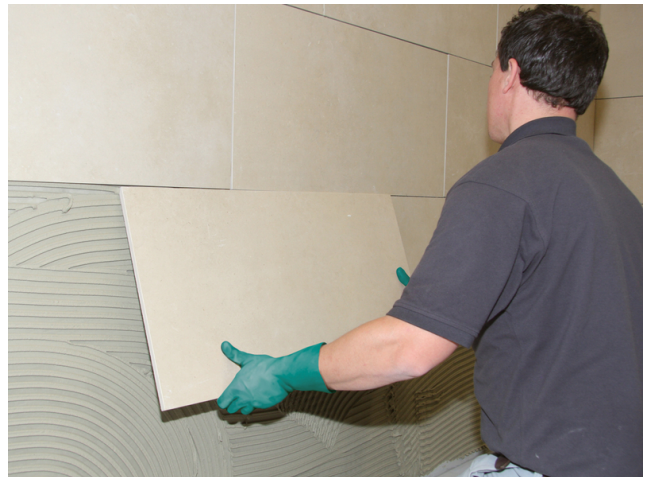
Großformatiges Feinsteinzeug einlegen und ausrichten. Fugennetz vor der Erhärtung auskratzen.
