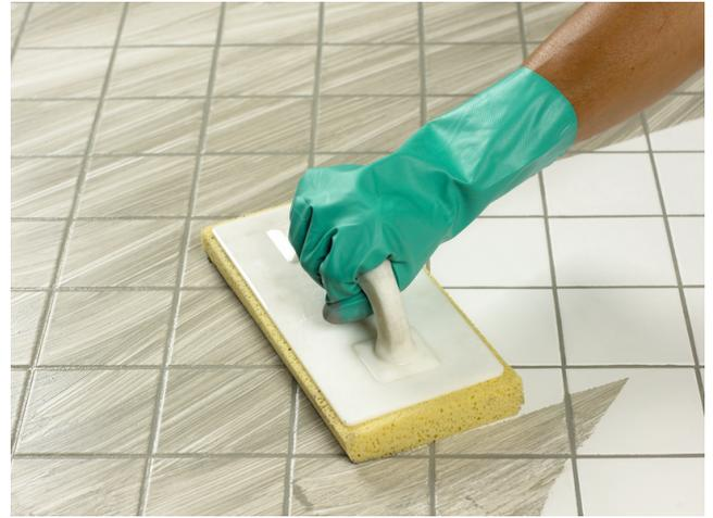
Entfernung der restlichen Schleier mit Sopro Schwammbrett und ausreichend frischem Wasser. Anschließend mit einem sauberen Tuch die Fläche abwischen.
