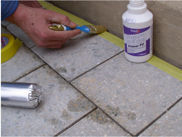
Die zuvor mit Klebeband abgeklebte Fuge wird mit Sopro Primer PU eingestrichen
