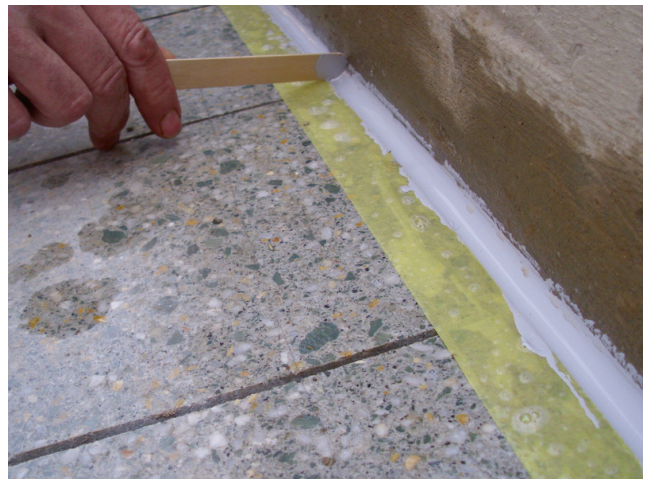
Die mit Sopro Glättmittel eingesprühte, offene Fuge mit entsprechendem Glättwerkzeug abziehen.
