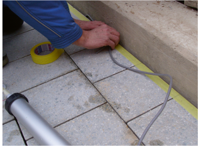
Einlegen einer PE-Rundschmuck nach Trocknung des Sopro Primer PU.
