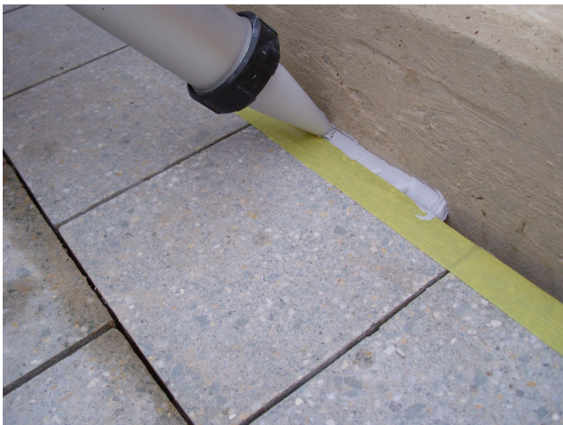
Hohlraumfreies und blasenfreies Einbringen des Sopro PU-Dichtstoffes mit einer Schlauchspritzpistole.
