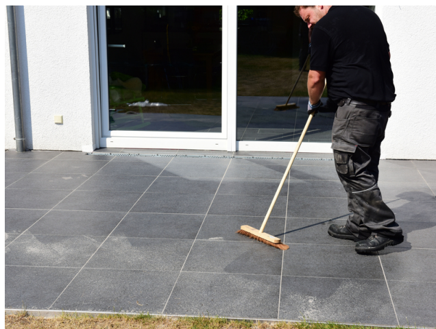
... und Mörtelreste ggf. abkehren.
