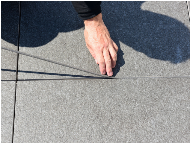
Eingeplante Bewegungsfugen sind mit einer Hinterfüllschnur zur Vermeidung einer Dreiflankenhaftung zu füllen.
