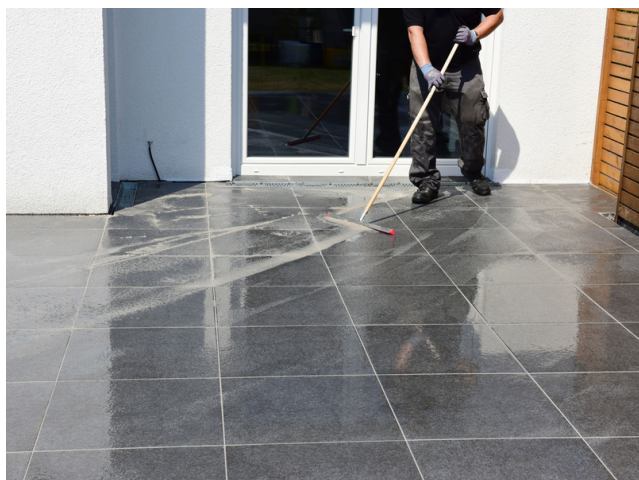
Überschüssigen Fugenmörtel abtragen ...
