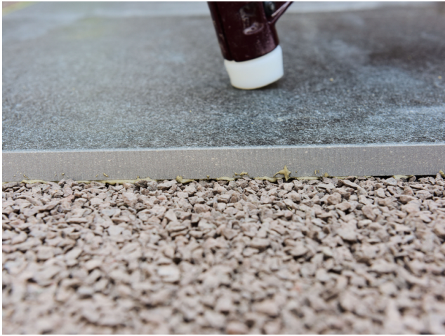
Die Platten einlegen und einklopfen.
