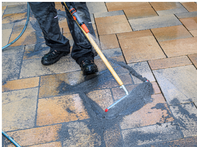
Verfugung von Betonwerksteinplatten mit Sopro Solitär® F20.
