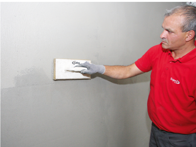
Der sauber abgezogene Putz kann nach 6 Stunden mit Fliesen belegt werden. Sollte keine Fliesenverlegung gewünscht sein, kann Sopro RAP 2® zusätzlich mit einem leicht angefeuchteten Schwammbrett ...
