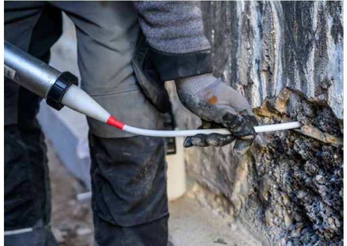
Einbringen von Sopro Verkieselungsgel mittels einer Spritze in das Mauerwerk
