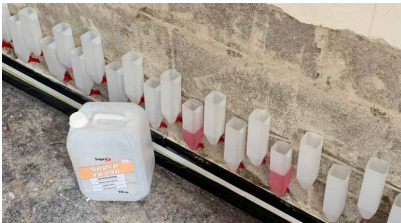
Einbringen von Sopro Verkieselung VK 690 in das Mauerwerk mithilfe der Trichter
