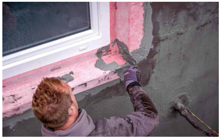
Nachträgliche Bauwerksabdichtung von außen mit zementärer Dichtschlämme bis auf Höhe 30 cm über GOK mit Anschluss an vorhandene Kellerfenster.
