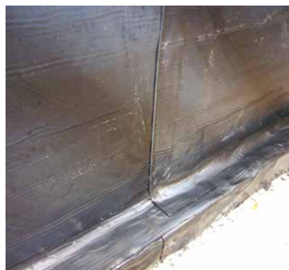
17 Abgedichtete Fläche mit Fußpunkt.
