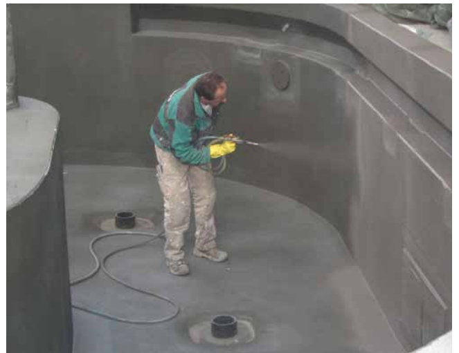
Abdichten eines Beckens im Spritzverfahren mit einer zementären flexiblen Dichtungsschlämme (z.B. Sopro DichtSchlämme 2-K).
