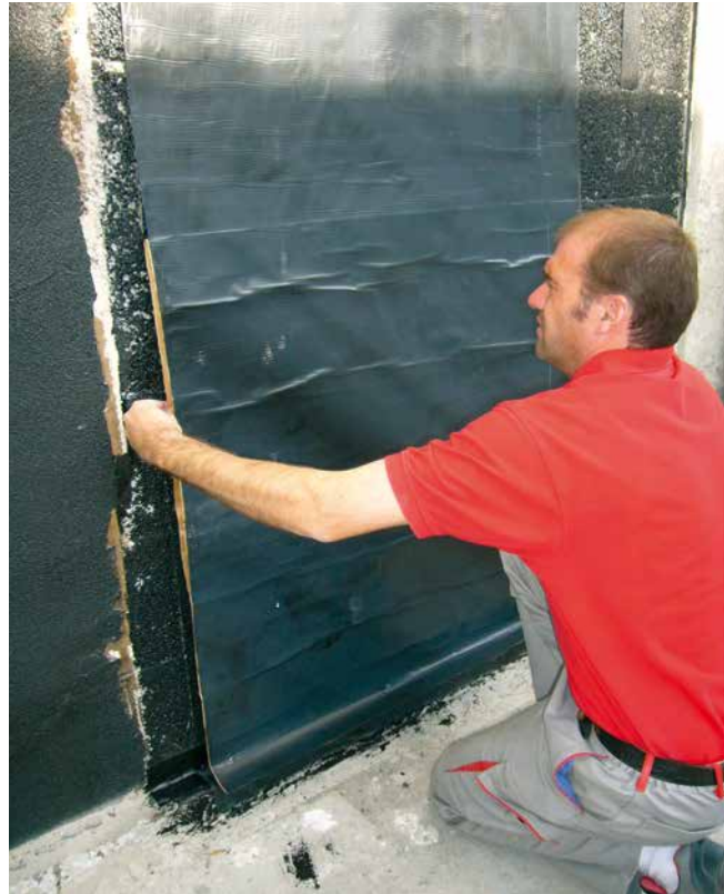
Abdichten eines Kellers nach DIN 18 195-4 mit SoproThene® Bitumen-Abdichtungsbahn.
