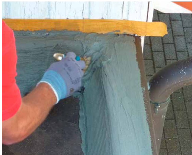
Abdichten einer Betonaufkantung an einem Dach.
