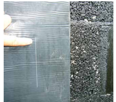
15 Arbeitserleichterung durch Überlappungsmarkierungen für die nächste Bahn.
