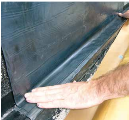
13 Schutzpapier vollständig entfernen und im Stoßbereich auf SoproThene® Klebeband (Verschweißungsband) überlappend verkleben.
