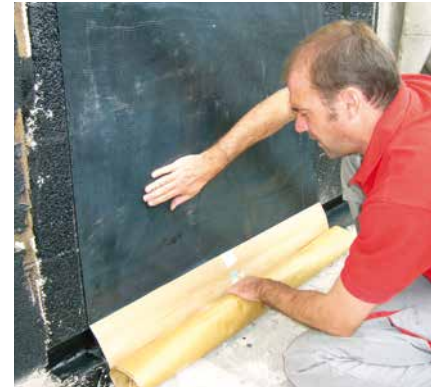
12 Andrücken der SoproThene® über die gesamte Wandfläche.
