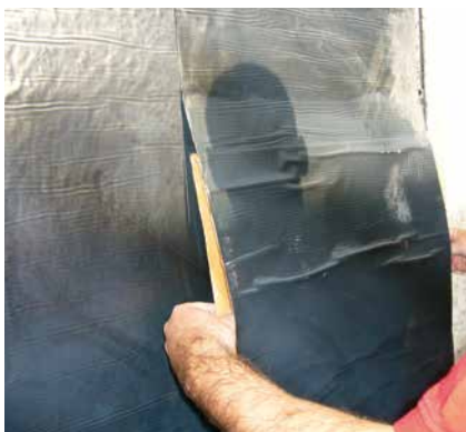
16 Ansetzen der nächsten Bahn.
