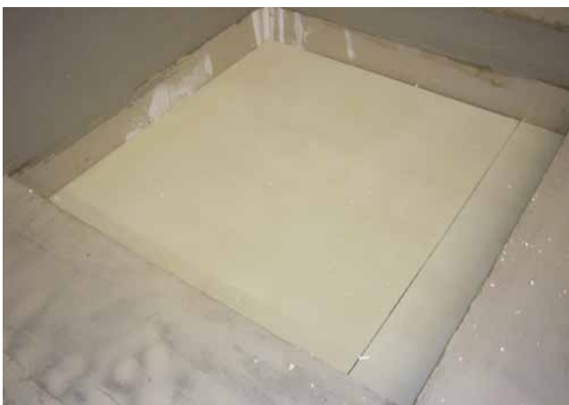
1 Ausgesparte Fläche im Estrich zum Aufstellen einer Duschtasse.
