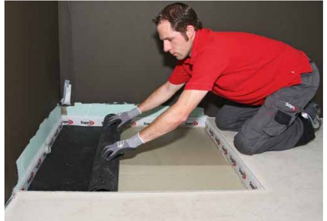
2 Verkleben einer Schallschutzbahn auf der planebenen Fläche mit Sopro's No.1 S1 Flexkleber.
