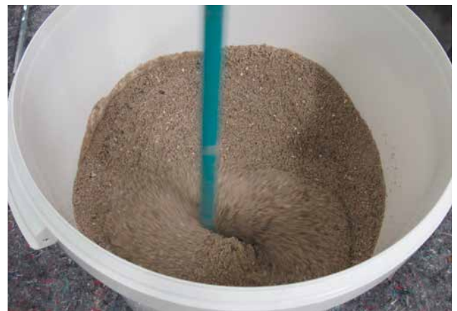
3+4 Anmischen eines harzgebundenen Mörtels zur Herstellung eines dünnschichtigen Estrichs (Sopro Bauharz und Sopro EpoxiEstrichkorn).
