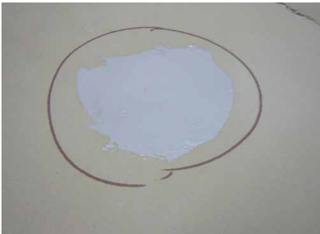
Sauber aufgefüllte Messstelle und somit ergänzte Abdichtfläche.
