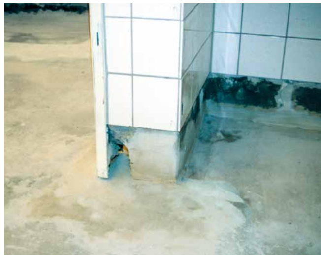
Türzargenhinterschneidung.
