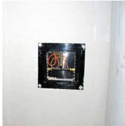
Sonderkonstruktion einer Unterputzarmatur mit Anflanschrahmen ...
