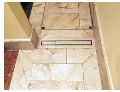
Rinne im Bereich des Durchganges.
