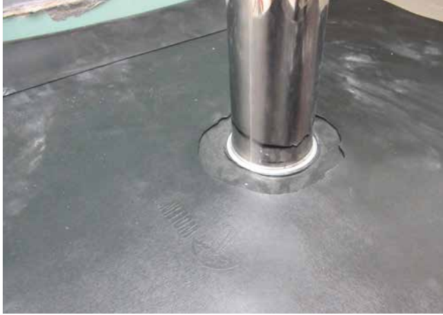
1 Erstes Hüllrohr mit Flansch und angeklebter Bahnabdichtung (System Wolfin) oberhalb der Dämmlage.
