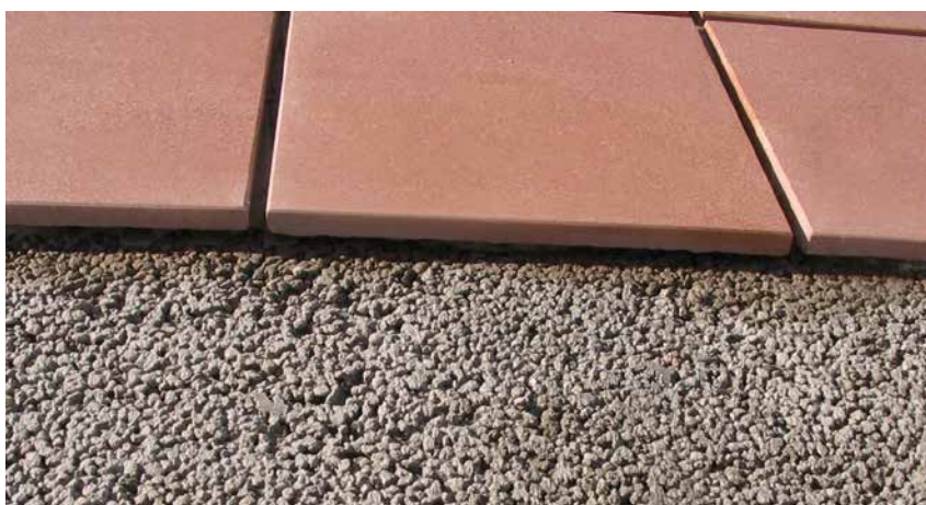
Fliesenverlegung auf Drainageestrich im Dünnbettverfahren.
