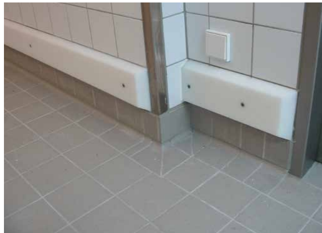
Ausgeführtes Sockeldetail mit Prallschutz.
