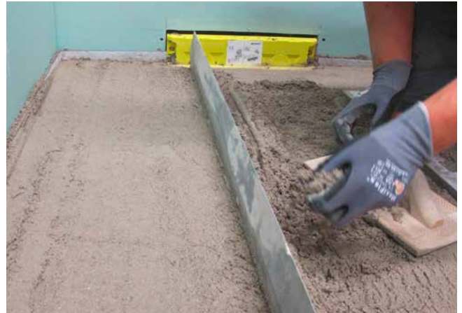
2 Einbau eines zementären Estrichs, hergestellt mit Sopro Rapidur® M1/Sopro Rapidur® M5. Die Schutzabdeckung dient hierbei als Abziehhilfe.
