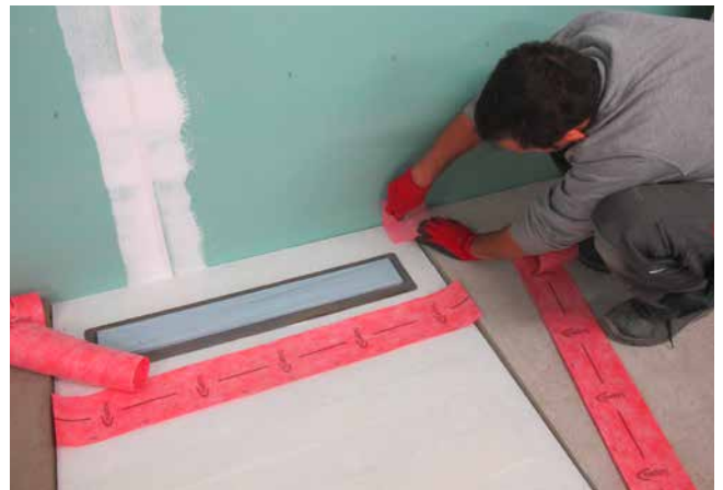
2 Vorbereiten der Komponenten für die Verbundabdichtarbeiten, unter anderem die Sopro AEB® Höhen-Pass-Stücke.
