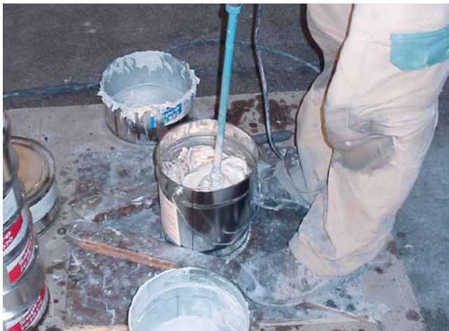
3 Sorgfältiges Anmischen der Komponenten A und B von Sopro PU-FlächenDicht mit entsprechendem Umtopfen.
