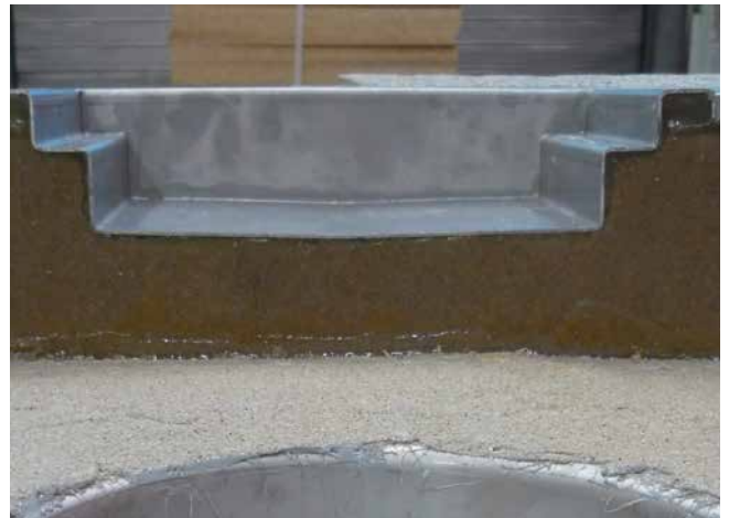
Sehr gut ist in dem Schnittmodell der kapillardichte Verguss unterhalb des Rinnenkörpers erkennbar.
