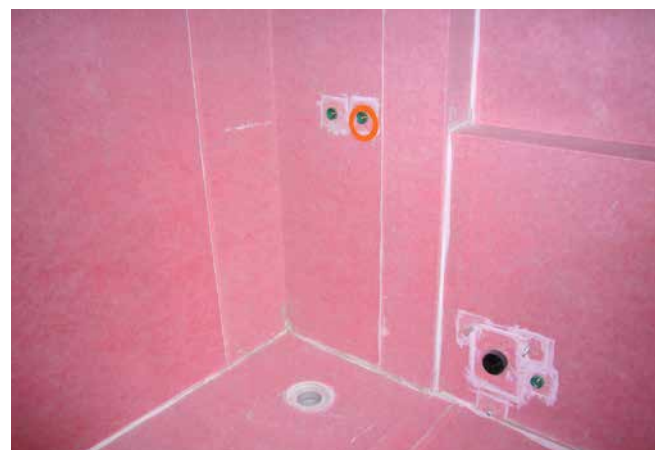
Fertig abgedichtetes Badezimmer - gut sind die Überlappungsbereiche der AEB-Bahn zu sehen, welche mit Sopro Racofix® RMK 818 Montagekleber wasserdicht verklebt sind.
