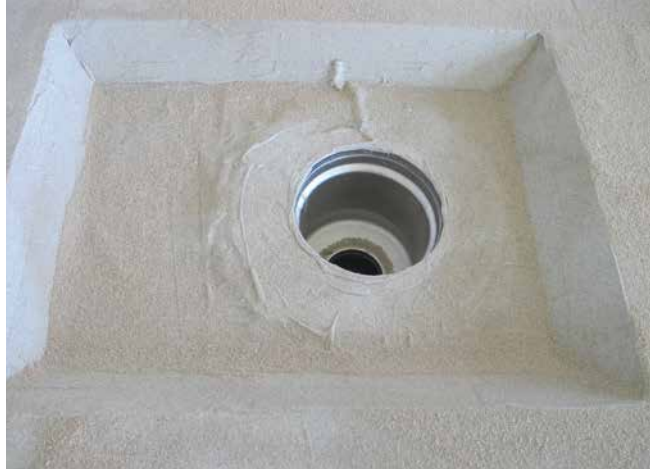
Abgedichtete und abgesandete Rinnenmulde. Die angefasten Estrichflächen sind gut zu erkennen.
