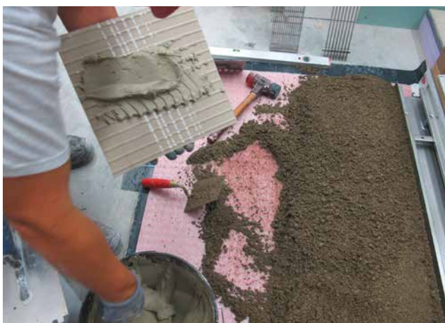
5 Die Fliesenverlegung findet unmittelbar „frisch-in-frisch“, z. B. mit Sopro megaFlex® TX, statt.
