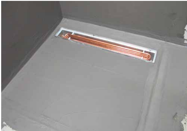
7 Abgedichtete Fläche mit der ACO Energiesparrinne.
