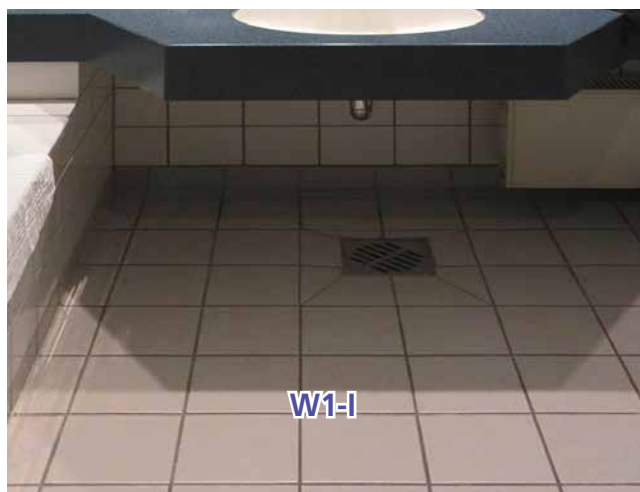
Badezimmer mit Bodenablauf von der Badewanne.
