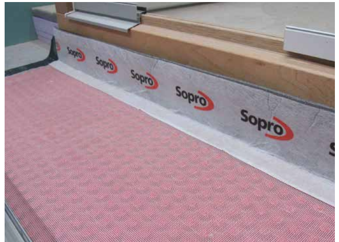
2 Bahnabdichtung mit Sopro DrainageMatte belegt. Am Türelement ist Sopro RandDämmstreifen aufgeklebt.
