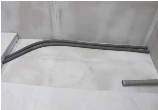
1 Ausgesparte Badewannenstellfläche mit Versorgungsleitungen auf dem Rohfußboden.
