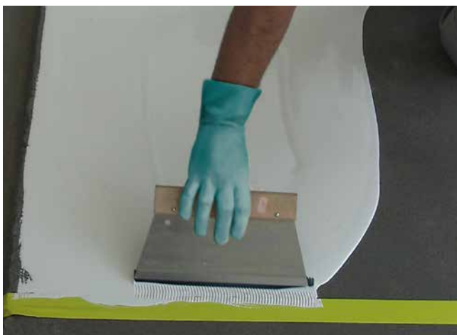
5 Applikation von Sopro PU-FlächenDicht am Boden in zwei Arbeitsgängen – Gesamtmindestschichtdicke 1 mm.
