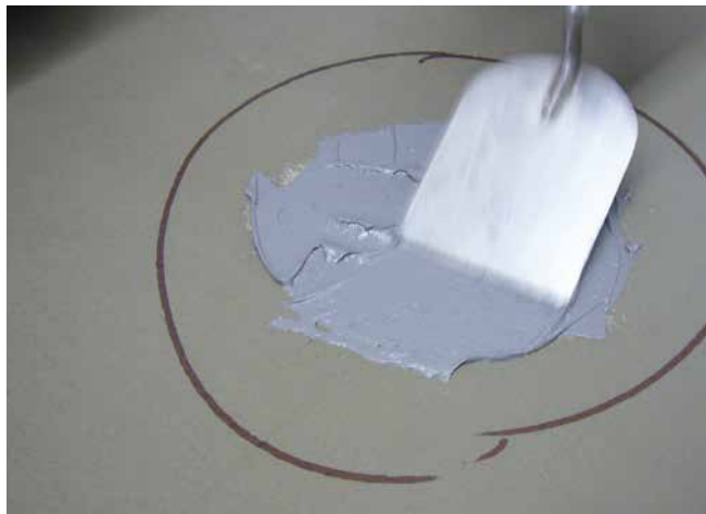
Verfüllen der Messstelle mit dem Verbundabdichtungsmaterial.
