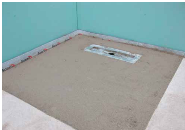
2 Duschfläche mit Gefälle zur Rinne, direkt in den frischen Estrich modelliert.
