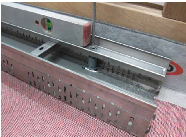
3 Die ACO-Abschlussrinne wird im Bereich der Tür auf die gewünschte Höhe eingestellt.
