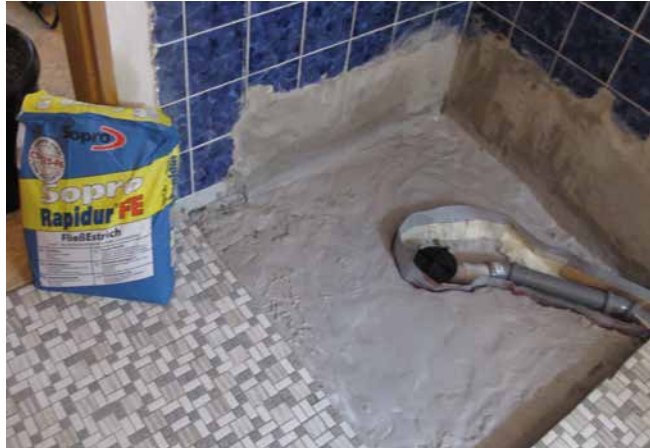
2 Herstellen einer planebenen Verlegefläche mit Sopro Rapidur® FE Fließestrich für die sichere, vollflächige Verlegung des Duschelementes.
