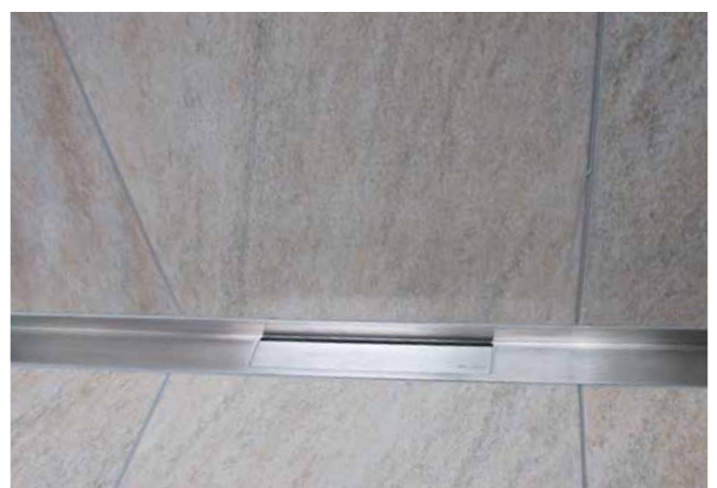
8 Nach der Verfugung mit Sopro DF10® DesignFuge Flex und Verfüllung der Bewegungsfugen mit Sopro SanitärSilicon ergibt sich eine schöne, leicht zu reinigende Gesamtlösung für die Duschfläche.
