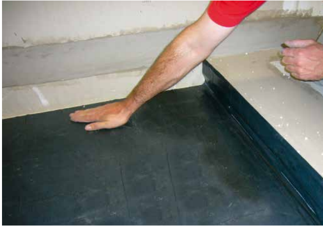
3 Nach dem Abziehen des Papiers wird die SoproThene® Bitumen-Abdichtungsbahn eingeklebt und festgedrückt.
