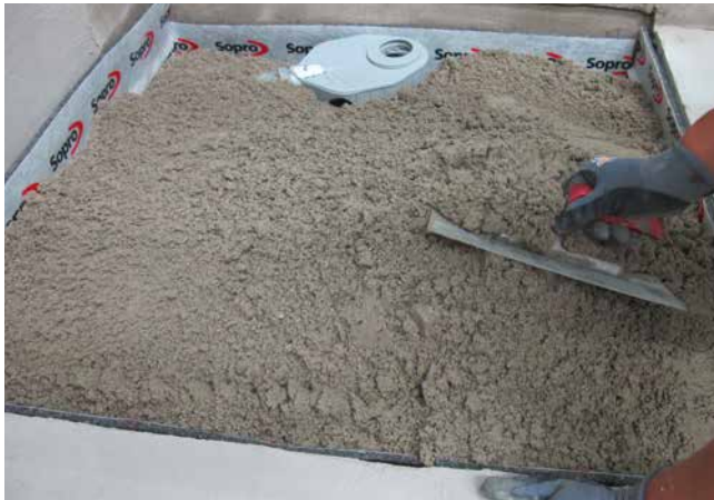
1 Vorbereitung des Estrichs Sopro Rapidur®M1/Sopro Rapidur®M5 und des Entwässerungstops für die Rinne mit Wandaufkantung.
