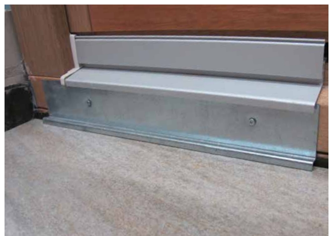
6 Die Fliesenverlegung erfolgt im Dünnbettverfahren mit Sopro megaFlex S2. Zum Türelement hin erfolgt der Abschluss mit einer Schiene.
