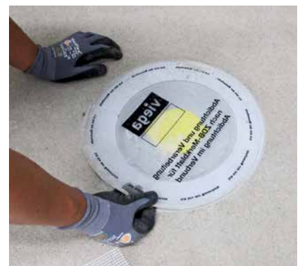
System Viega: Der Bodenablauf besitzt einen Klebeflansch, auf welchem die Verbundabdichtung appliziert wird.
