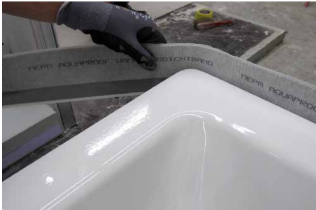
1 Ankleben des Wannenabdichtbandes (System MEPA – Pauli und Menden GmbH) an den Wannenrand.
