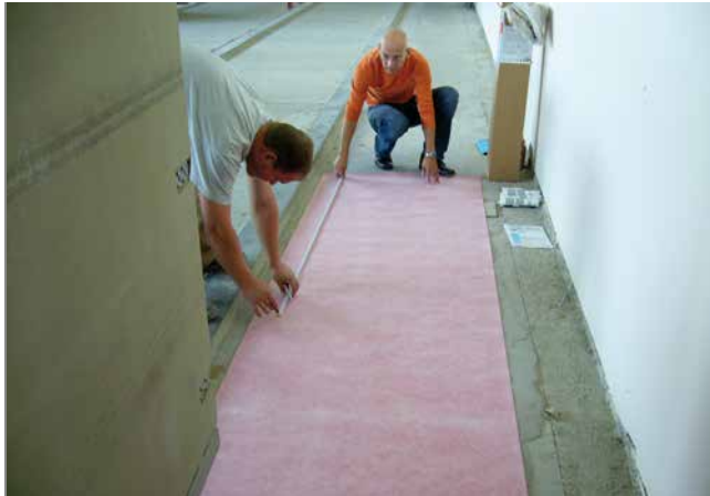
1 Zuschneiden der Sopro AEB® Abdichtungs- und Entkopplungsbahn für die anschließende Verlegung an Wand- und Bodenflächen.
