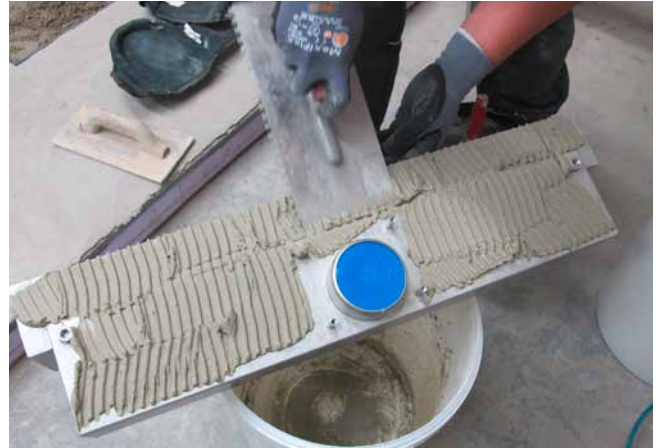
2 Abpachteln der Rinnenrückseite mit Fliesenkleber (Sopro's No. 1 S1 Flexkleber) zur Herstellung eines guten Haftverbundes zum Estrichmörtel.
