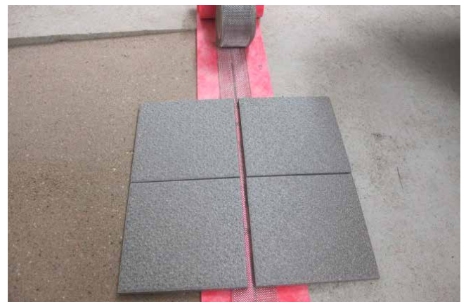
Dichtband und Schutzzeile (Sopro Schnitenschutzband) gegen Zerschneiden des Bandes.
