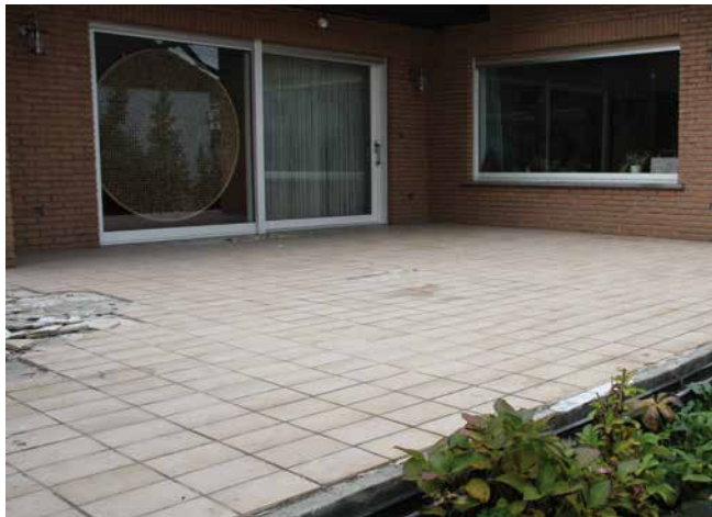
1 Alter, tragfähiger Fliesenbelag auf einer Terrasse.
