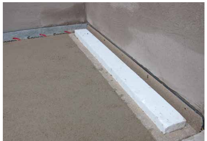
4 Einbau der Rinne im Estrich (Sopro Rapidur®M1/Sopro Rapidur®M5).
