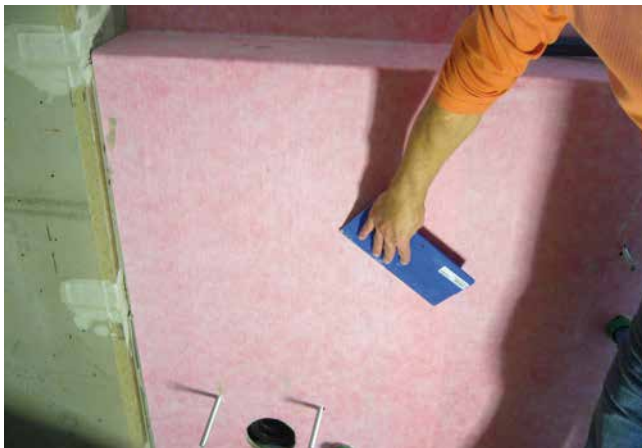
3 Nach dem Einlegen der Sopro AEB® Abdichtungs- und Entkopplungsbahn in das Mörtelbett ist die Bahn sorgfältig mittels Rolle oder Andrückbrett in das Mörtelbett einzudrücken.
