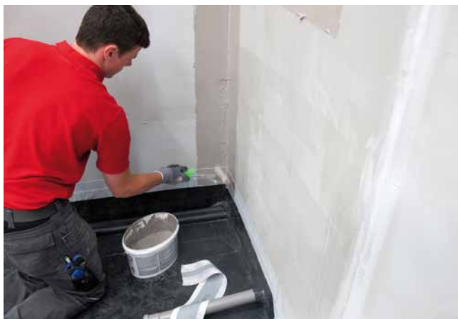
5 Abdichten der Wand- und Bodenflächen mit Sopro FlächenDicht flexibel.
