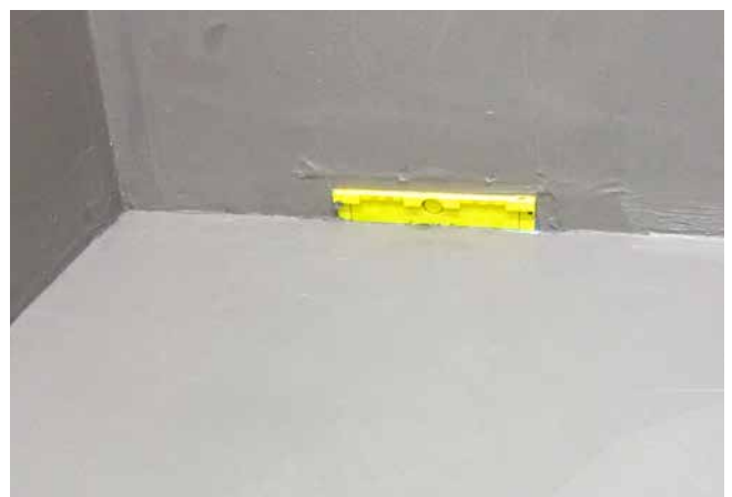
6 Abgedichtete Boden- und Wandflächen, nach der Trocknung bereit für die Fliesenverlegung. Keramische Beläge sowie Natursteinbeläge lassen sich hier wie folgt (keine Aufkantung vorhanden) sehr gut verlegen.
