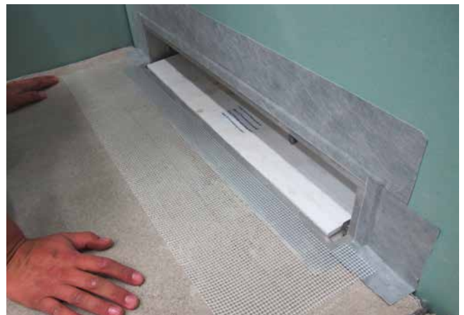
4 Duschfläche (Sopro Rapidur® M1/Sopro Rapidur® M5) mit angeschlossener Wandentwässerungsrinne.
