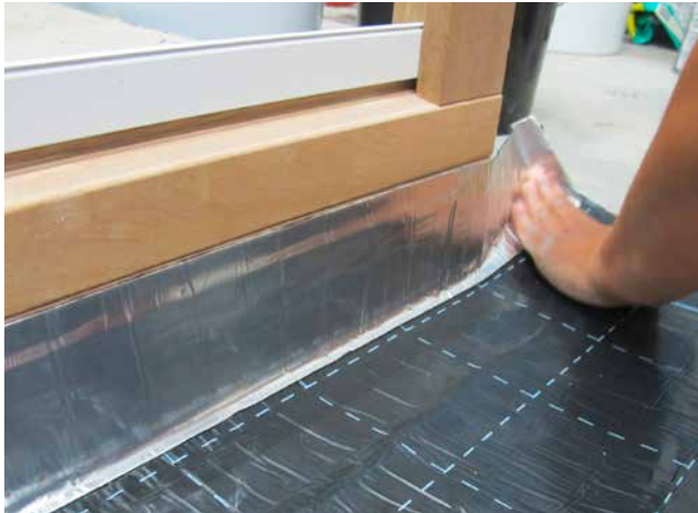
1 Bahnabdichtung mit SoproThe Abschlussband Aluminium am Türelement.
