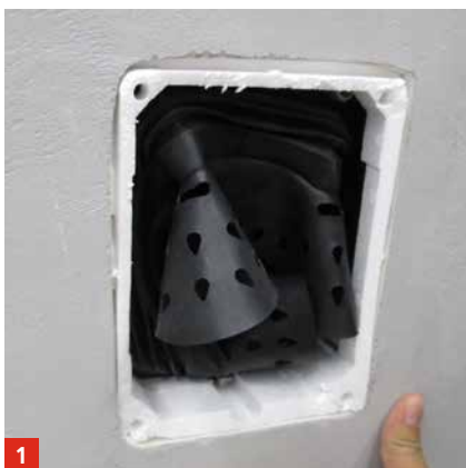
Sicheres Eindichten einer Wandarmatur mit Sopro FlächenDicht flexibel oder Sopro DichtSchlämme Flex 1-K.
