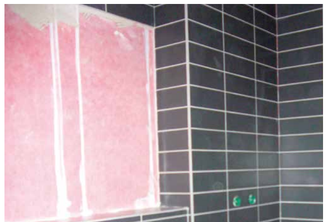
5 Eine Fliesenverlegung kann kurze Zeit später, nach Beendigung der Abdichtungsarbeiten, auf der Sopro AEB® Abdichtungs- und Entkopplungsbahn mit einem Dünnbettmörtel (Sopro's No. 1 S1 Flexkleber) erfolgen.
