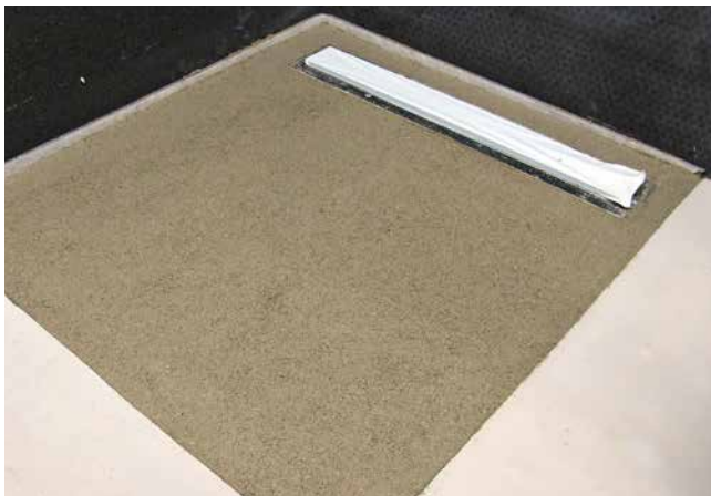
3 In den Estrichmörtel (Sopro Rapidur® M1/Sopro Rapidur® M5) fertig eingebaute ACO-Rinne.
