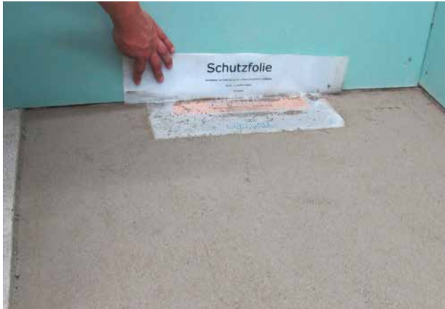
3 Eingebautes Bodenablaufelement. Dieses besitzt eine angeschweißte Dichtmanschette zur Erleichterung der Abdichtungsarbeiten im Bereich der Wand.
