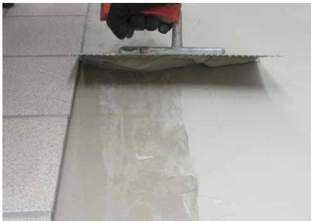
4 Überlappendes Andichten der Duschfläche an die Bestandsfläche.
