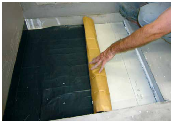
2 SoproThere® Bitumen-Abdichtungsbahn unterhalb der Duschtasse.
