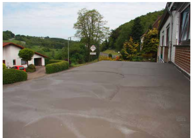
Terrasse/Balkon abgedichtet mit einer zementären, flexiblen Dichtungsschlämme (Sopro TurboDichtSchlämme), bereit für die folgende Fliesenverlegung.
