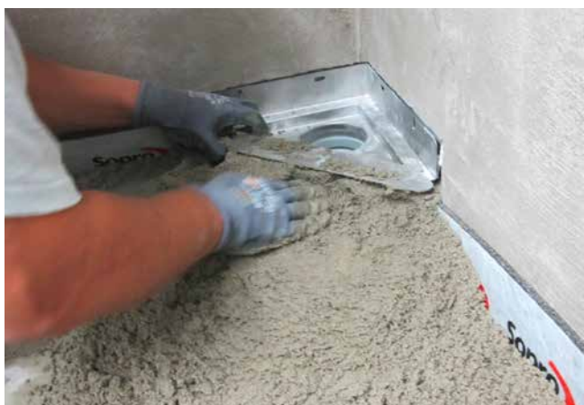
3 Im Bereich der Wand ist eine Aussparung vorzunehmen, damit das Eckentwässerungselement bündig mit der Wand und bewegungsfrei eingebaut werden kann.
