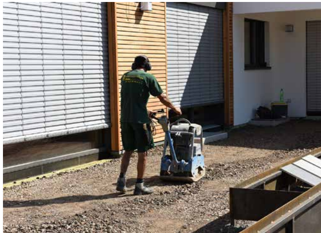
Verdichten der ungebundenen Trag- und Frostschutzschicht.
