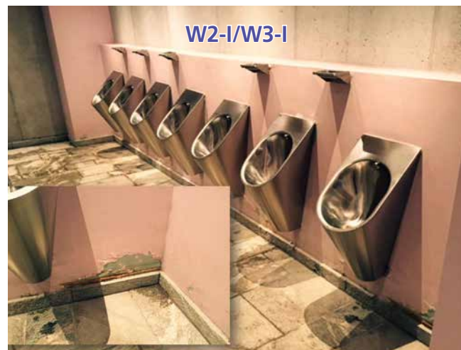
Die Toilettenanlage in einer Skihütte/einem Stadion hingegen ist aufgrund der sehr hohen Belastung bei W2-I bis W3-I festzulegen.
