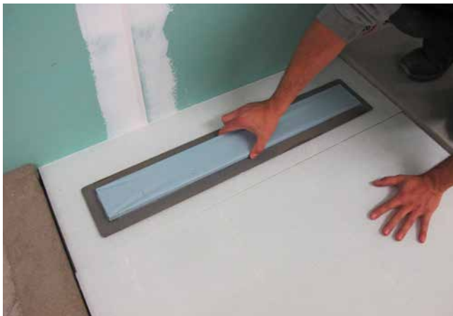
1 Einpassen der Rinne in das ACO Trockenbauelement.
