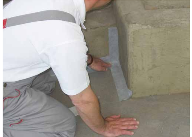
2 Verkleben von Sopro FlexDichtBand im Bereich von Bewegungsfugen.
