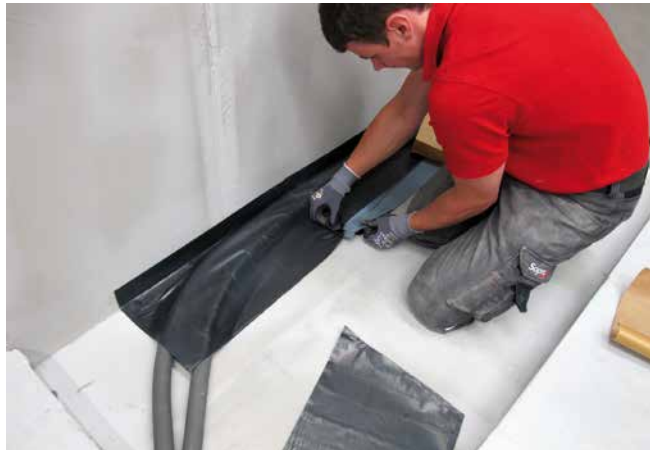
2 Abdichten der Badewannenstellfläche mit SoproThene® Bitumen-Abdichtungsbahn.
