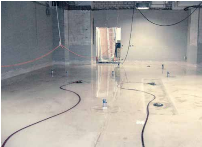
Prüfung der Bodenabdichtung auf Dichtigkeit durch Flutung.
