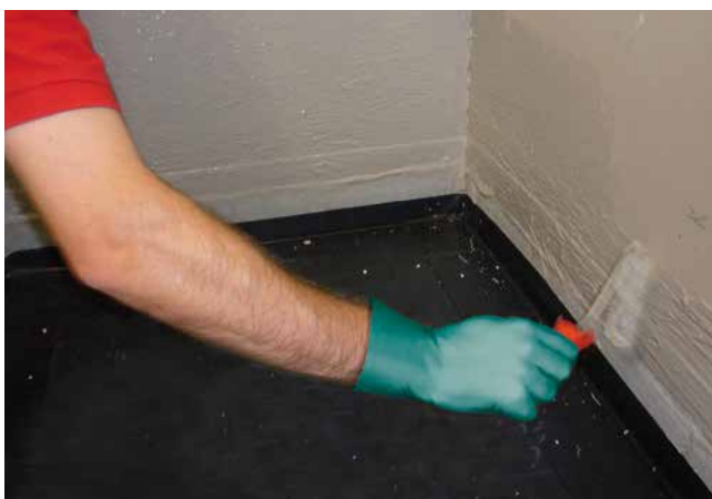
7 Abdichten der Wand- und Estrichflächen, z.B. mit Sopro Dicht-Schlämme Flex 1-K.
