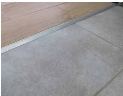
Türschwelle mit Schiene (Schulter).
