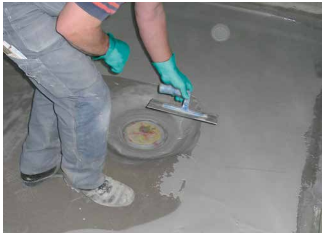
Applikation der flexiblen, mineralischen Dichtungsschlämme.
