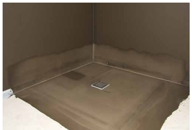
6 Abgedichtete Fläche, bereit für die folgende Fliesenverlegung.
