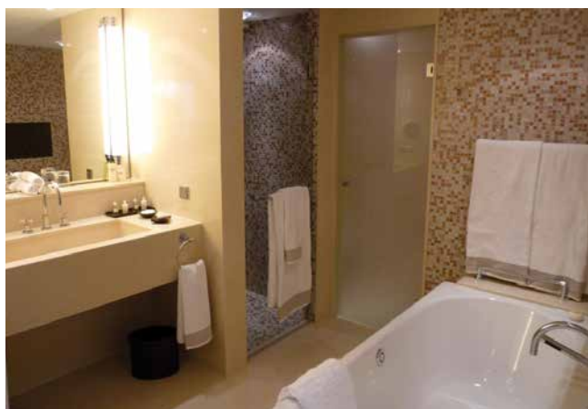
Hotelbadezimmer mit Duschrinne im Duschbereich.
