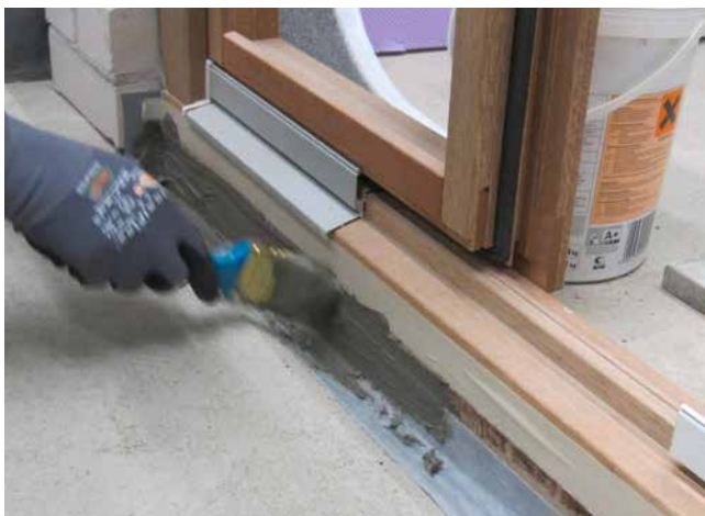
3 Abdichten der Fuge mit Sopro TurboDichtSchlämme 2-K.
