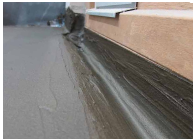
4 Abgedichtete Balkonfläche mit Anschluss an das Türelement.
