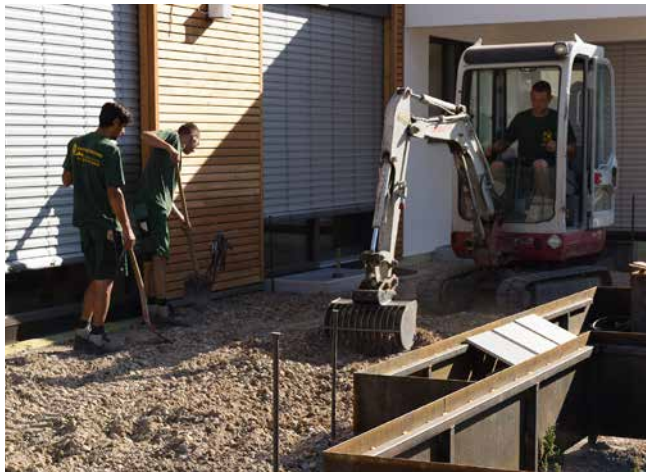
Einbau der ungebundenen Frostschutzschicht.
