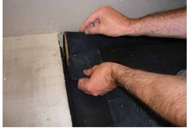
4 Aufgrund der selbstklebenden, verschweißenden Eigenschaft der SoproThene® Bitumen-Abdichtungsbahn lassen sich Bereiche wie Ecken etc. durch kleine Teilstücke leicht abdichten.
