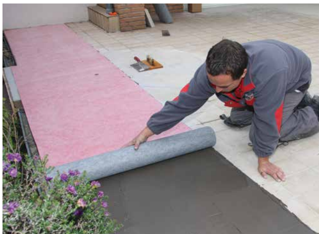
4 Verlegen der AEB® plus Abdichtungs- und Entkopplungsbahn plus in das vorbereitete Mörtelbett.
