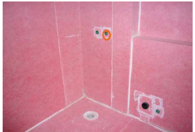
4 Alle Stöße sowie die Manschetten im Bereich von Durchdringungen (Rohre, Bodenabläufe etc.) sind mit Sopro Racofix® Montagekleber (S) wasserdicht zu verkleben.
