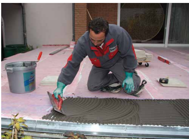
11 Aufkämmen von Sopro megaFlex S2 auf der abgedichteten Fläche.
