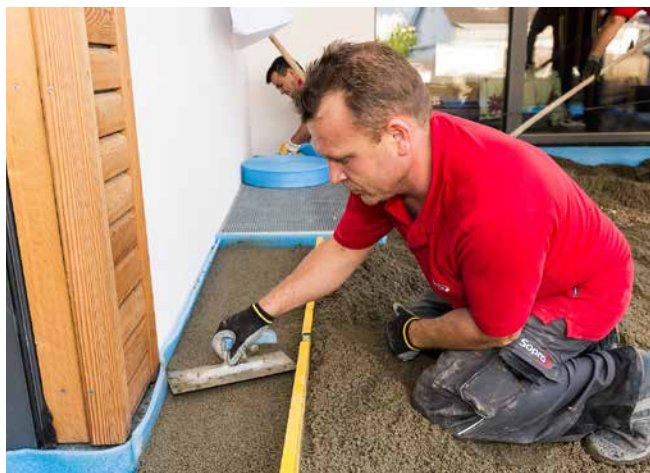
Verdichten und Abziehen der drainagefähigen Mörtelschicht auf gewünschter Höhe.
