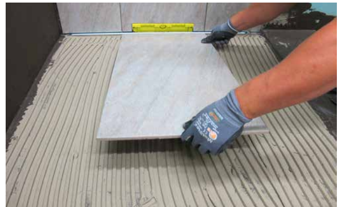
Verlegung der Fliese auf der Verbundabdichtung mit einem systemkonformen Dünnbettmörtel.
