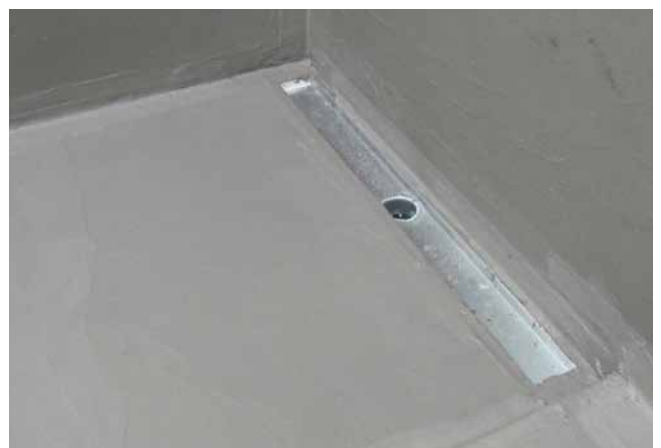
6 Abgedichtete Duschfläche (2 Arbeitsgänge), bereit für die Fliesenverlegung.
