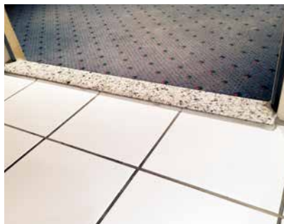
Belag mit Natursteinschwelle.
