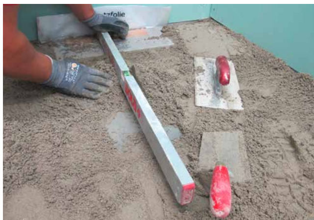
2 Einbau des Bodenablaufelementes in den Estrich mit Sopro Rapidur® M1/Sopro Rapidur® M5 mit entsprechendem Gefälle.
