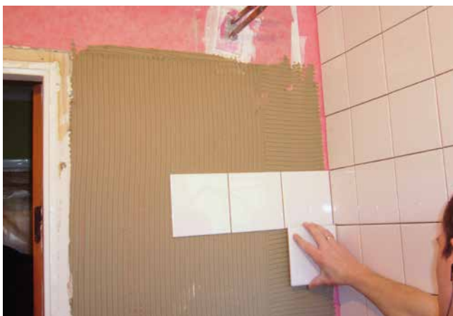
5 Eine Fliesenverlegung kann kurze Zeit später, nach Beendigung der Abdichtungsarbeiten, auf der Sopro AEB® Abdichtungs- und Entkopplungsbahn mit einem Dünnbettmörtel (Sopro's No. 1 S1 Flexkleber) erfolgen.
