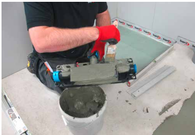
1 Einstreichen des Ablaufgehäuses mit einem Haftvermittler zur besseren Anbindung an den dünn-schichtigen Estrich.
