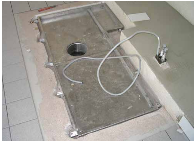
Eingesetzte Rinne in abgedichtete Rinnenmulde.
