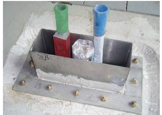
Durchdringungsbauteil mit Pressdichtflansch eingedichtet mit einer Verbundabdichtung.
