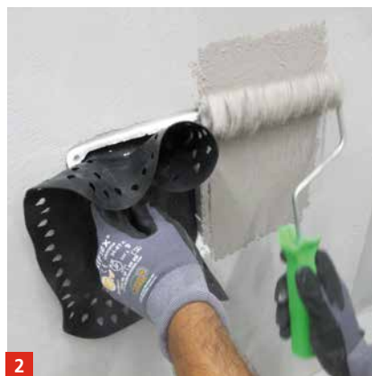
Sicheres Eindichten einer Wandarmatur mit Sopro FlächenDicht flexibel oder Sopro DichtSchlämme Flex 1-K.
