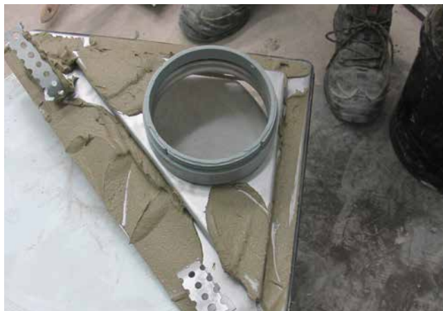
2 Zur Herstellung eines guten Haftverbundes zwischen Estrichmörtel und Eckentwässerungselement wird dieses rückseitig mit Sopro's No.1 S1 Flexkleber abgespachtelt.
