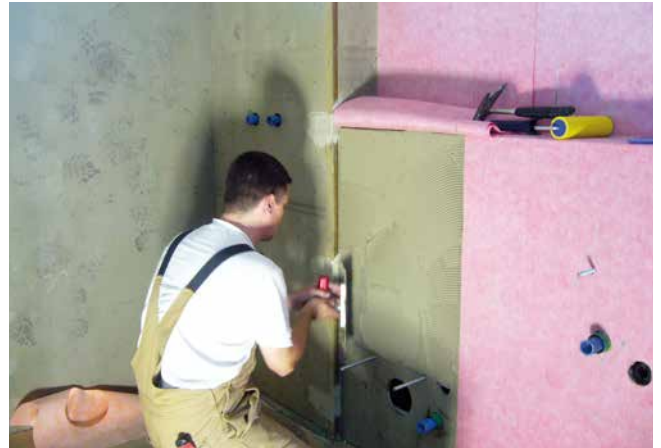
2 Aufspachteln des Fliesenklebers (Sopro's No. 1 S1 Flexkleber) mit einer feinen Zahnpachtel. Die Flächen sind im Vorfeld mit Sopro Grundierung zu grundieren.
