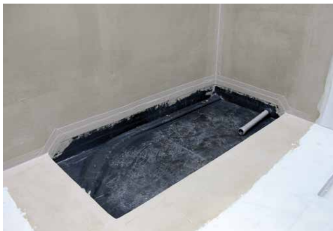
6 Komplett abgedichtete Badewannenecke, bereit für den Einbau und Anschluss der Badewanne.
