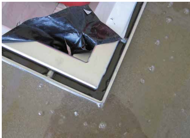
Der umlaufende Edelstahlrahmen ist gut zu erkennen. Die Bolzen werden später durchtrennt, der Rinnenkörper kann sich so frei bewegen.
