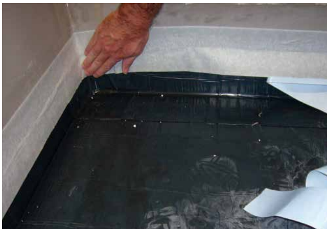
5 Ist die abgedichtete Wanne aus SoproThene® Bitumen-Abdichtungsbahn hergestellt, sind die aufgehenden Enden im Bereich Wand und Estrich mit dem SoproThene® Abschlussband Vlies zu verkleben.
