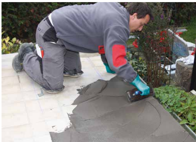
3 Auftragen von Sopro megaFlex S2 zur Verklebung von Sopro AEB® plus Abdichtungs- und Entkopplungsbahn plus.
