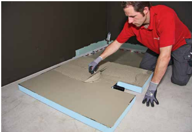
3 Auf der Rückseite des Duschelementes wird Fliesenkleber (Sopro's No.1 S1 Flexkleber) für die Verklebung zum Untergrund aufgetragen. Der Untergrund wird ebenfalls mit Fliesenkleber abgespachtelt.
