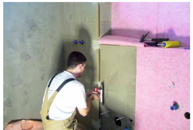
Abdichten eines Badezimmers mit einer bahnenförmigen Fliesenverbundabdichtung (Sopro AEB® Abdichtungs- und Entkopplungsbahn).
