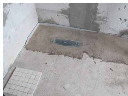
Duschfläche hergestellt aus Zementmörtel (Sopro Rapidur® B5).
