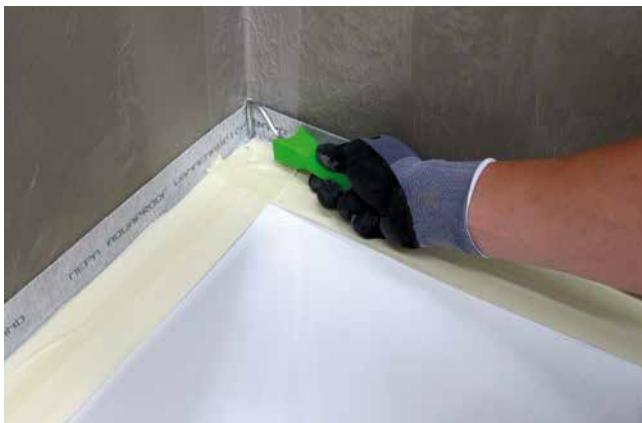
3 Das Wannenabdichtband lässt sich aufgrund einer senkrechten Perforierung auch in Ecken gut verkleben.
