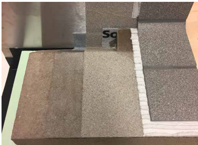
Anschluss mit Hohlkehlssockel an der Kühlzelle.
