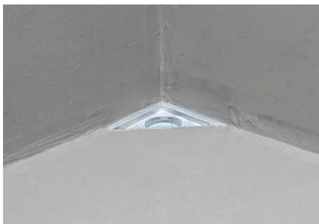
6 Abgedichtete Duschfläche mit Sopro DichtSchlämme Flex 1-K.
