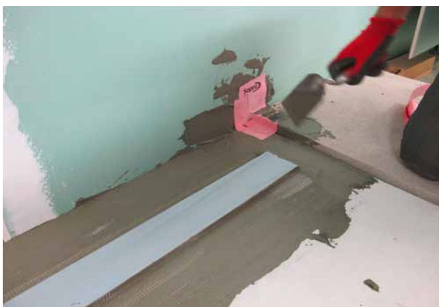
3 Im Bereich der Rinne wird ein Gewebe in die Sopro TurboDicht-Schlämme eingearbeitet. Das Sopro AEB® Höhen-Pass-Stück wird ebenfalls eingesetzt.
