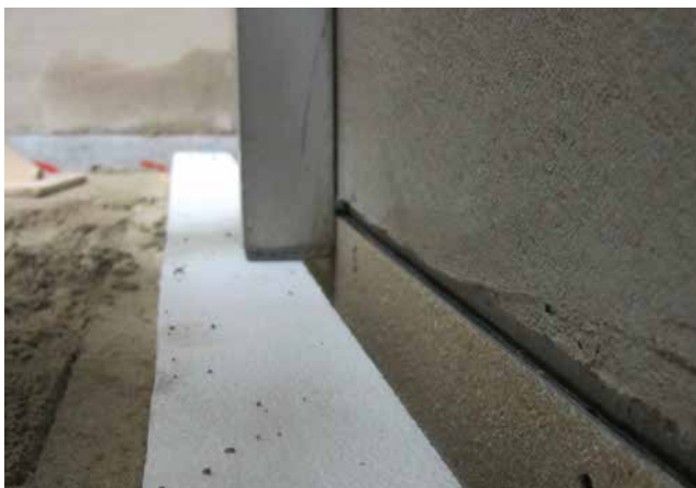
3 Einbau der Rinne bündig mit der Wand. Die Rinne muss frei beweglich bleiben.
