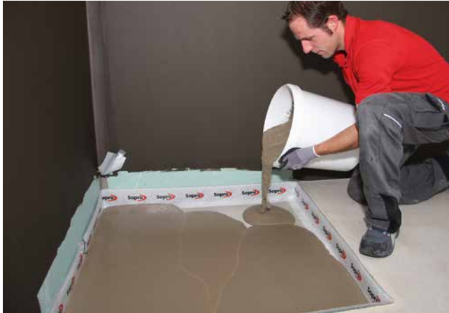
1 Herstellen einer planebenen Fläche mit Sopro Rapidur® FE Fließ-Estrich für die Aufnahme des Duschelementes.
