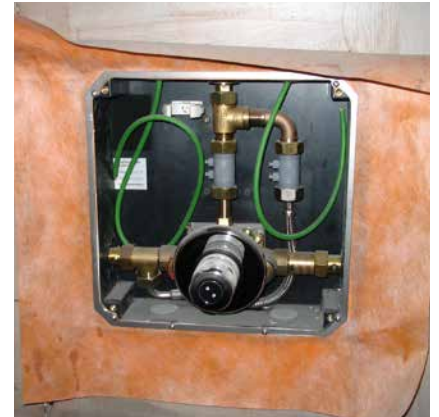
... oder mit Dichtmanschette zum Eindichten in die Verbundabdichtung.
