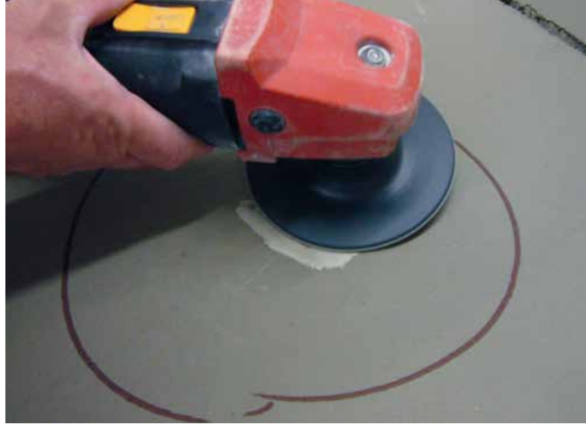
Anschleifen der Schnittkanten zur Herstellung einer Übergangszone.
