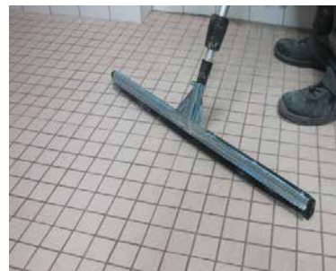
Entfernung des Wassers mittels Gummischieber.
