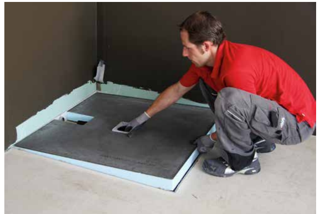
4 Einsetzen des Duschelementes in die Duschecke bzw. Ausparung des Estrichs.
