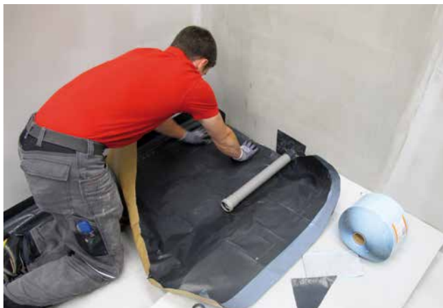
3 Flächenabdichtung und Einbindung einer Rohrdurchdringung (Abwasseranschluss) mit SoproThene® Bitumen-Abdichtungsbahn.
