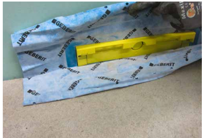
4 Die bereits am Geberit-Einlaufkörper angeschweißte Manschette wird herausgefaltet und anschließend mit der flüssig zu verarbeitenden Verbundabdichtung (Sopro TurboDichtSchlämme 2-K) verklebt.
