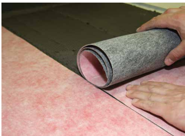
6 Die Sopro AEB® plus Abdichtungs- und Entkopplungsbahn plus wird Stoß an Stoß verlegt.
