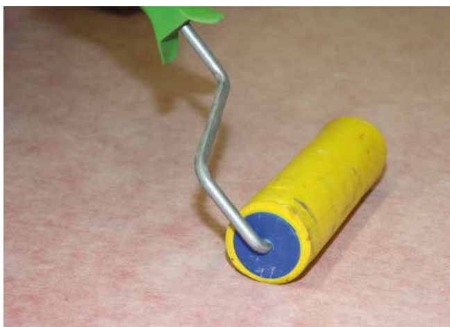
5 Andrücken der AEB® plus Abdichtungs- und Entkopplungsbahn plus in das Kleberbett.
