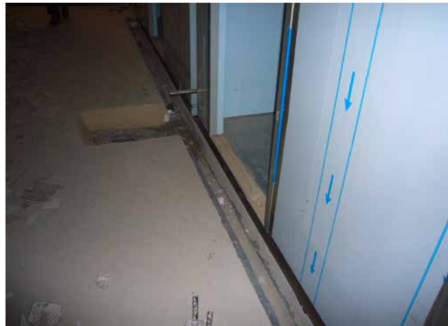
Kühlzelle in einer Großküche.
