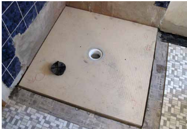
4 Eingesetztes Duschelement (MEPA – Pauli und Menden GmbH), bereit für die Abdichtungsarbeiten.
