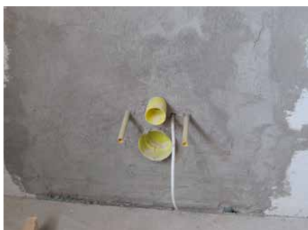
Wandfläche mit Zementmörtel (Sopro RAM 3®) verputzt/gespachtelt.
