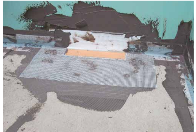
4 Abdichten des Bodenablaufelementes und der Fläche mittels Dichtbändern und Gewebeeinlagen sowie Sopro TurboDichtSchlämme 2-K.
