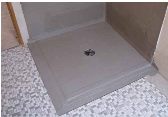
5 Abgedichtetes Duschelement mit Sopro FlächenDicht flexibel, ausgeführt in zwei Arbeitsgängen.
