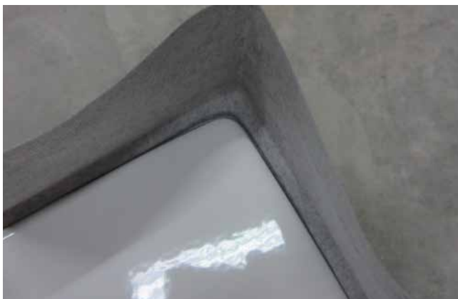
1 Der Dichteckenradius passt sich an die Wanne an, während das obere Ende zu einer scharfkantigen 90°-Ecke zur Wand hin geformt ist.
