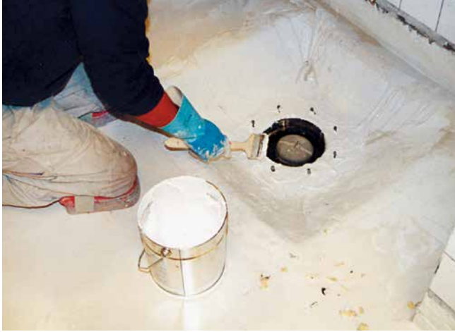
Verarbeitung von Sopro PU-FlächenDicht und Anschluss an Flansch.
