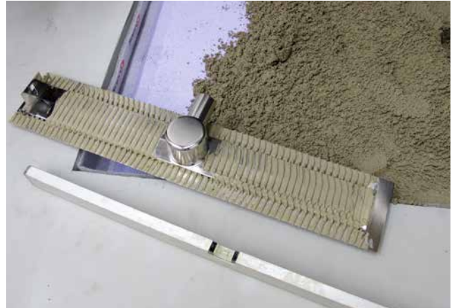
2 Die mit Fliesenkleber (Sopro's No. 1 S1 Flexkleber als Haftbrücke) rückseitig abgespachtelte ACO-Rinne wird in den frischen Estrichmörtel (Sopro Rapidur® M1/Sopro Rapidur® M5) eingearbeitet.
