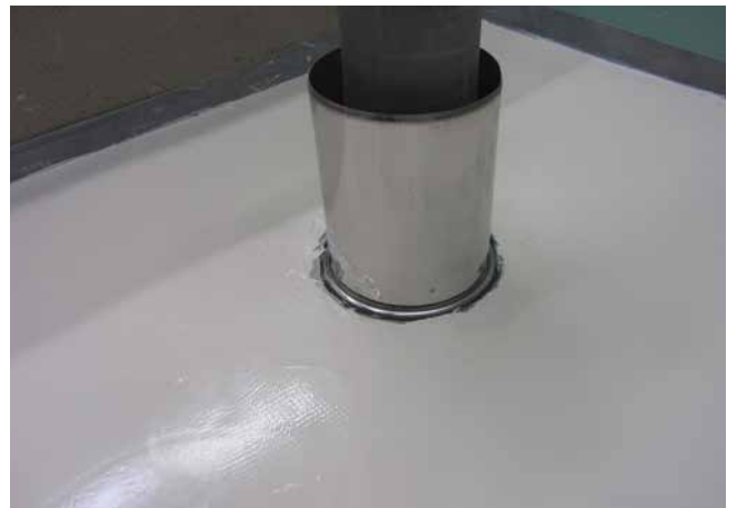
4 Mit Sopro PU-FlächenDicht eingedichtetes Hüllrohr.
