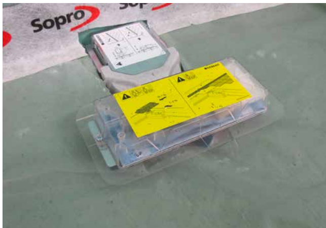
1 Bodenablauf in der Duschfläche positioniert.
