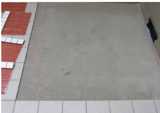
5 Die Fläche ist mit einer Verbundabdichtung (Sopro DichtSchlämme Flex 2-K) abgedichtet. Nach der Trocknung erfolgt die Verlegung des Mosaiks.
