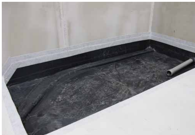
4 Fertig abgeklebte Badewannenstellfläche, bereits mit SoproThene® Abschlussband Vlies am Rand abgeklebt für die folgende Verbundabdichtung (Sopro FlächenDicht flexibel).
