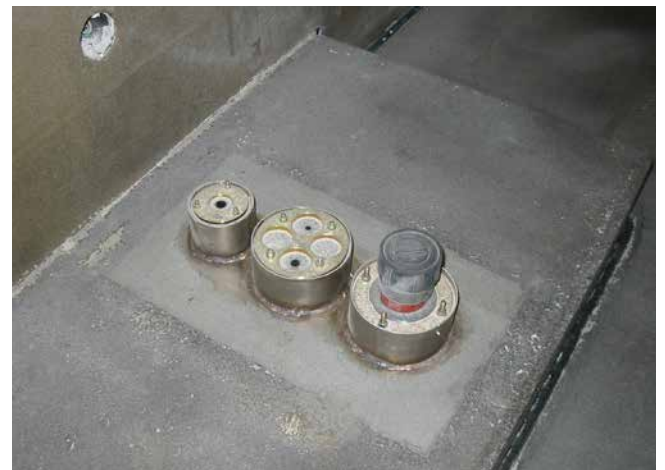
Durchdringungsplatte mit Gummidichtungsringseiben.
