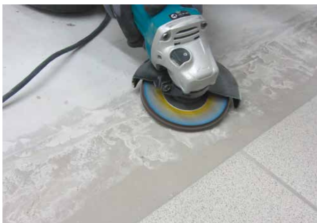
3 Anschleifen der Abdichtungsebene und Entfernen der Kleberreste mittels kleinem Winkelschleifer.
