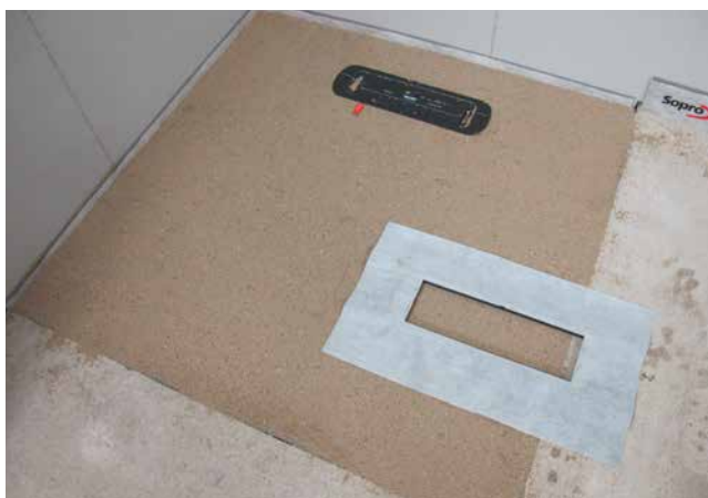
6 Fertig hergestellte Fläche, bereit für die folgenden Abdichtarbeiten.
