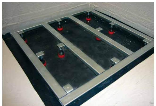
8 Komplett abgedichteter Bereich mit eingestelltem Wannenträger, vorbereitet für die Installation einer Duschtasse.
