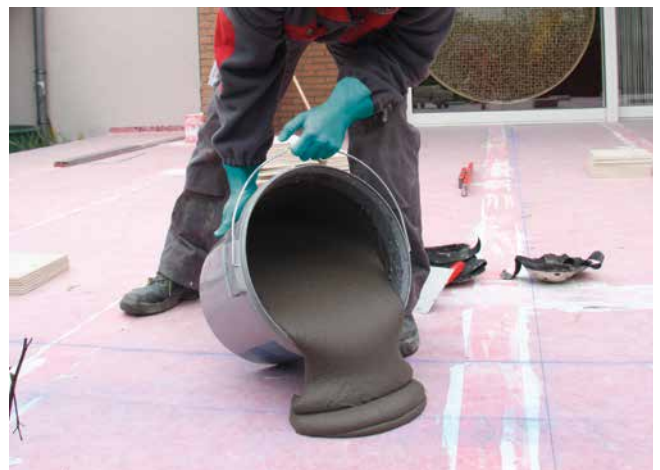
10 Sopro megaFlex S2 – flexibler Dünnbettmörtel mit Fließbetteigenschaften.
