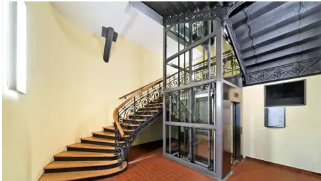
KONE ProSpace™ Plus ist eine selbsttragende Aufzugslösung, die nachträglich bis zu 16 Etagen verbindet.
