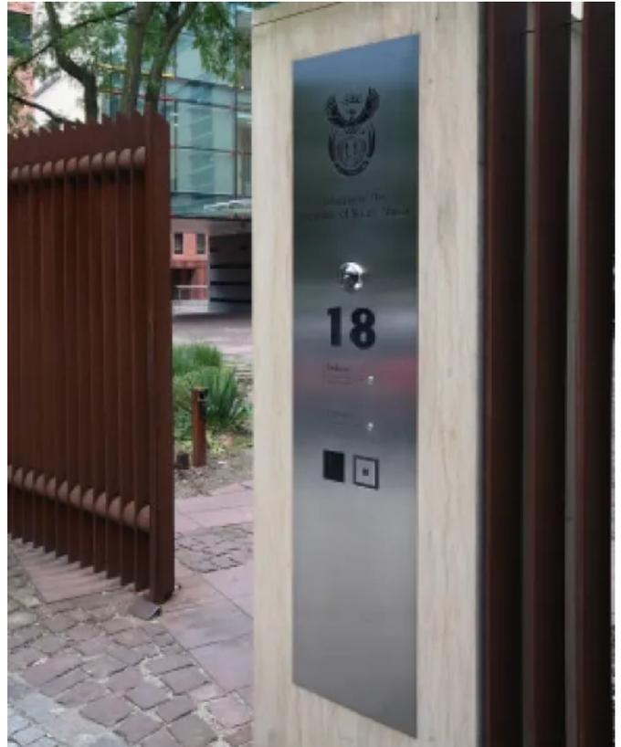
Außenstation für Inoplan mit Video-Sprechanlage
