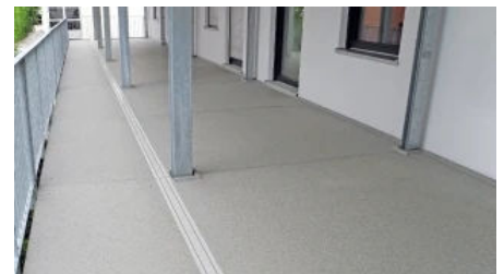
Detail mittlere Entwässerungsrinne
