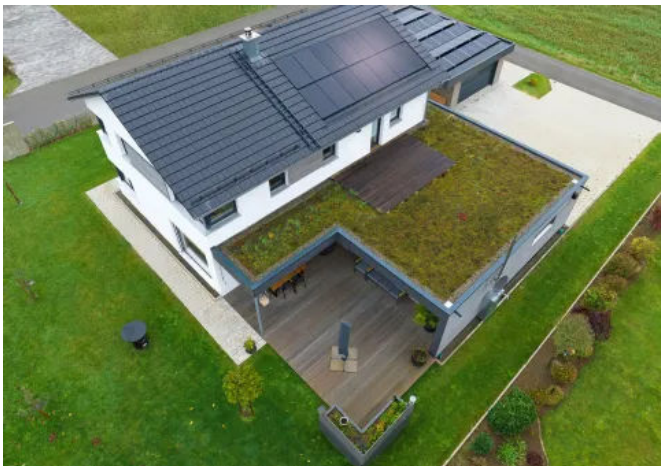
Gründach privates Einfamilienhaus in Süddeutschland
