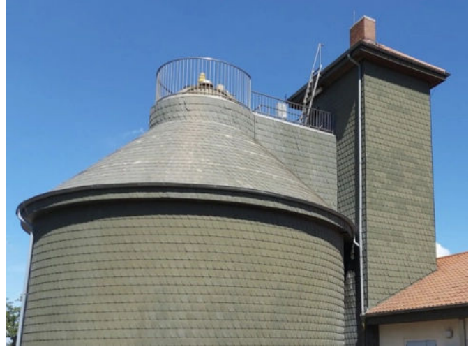
Für stark beanspruchten Betonbauteile: System StoConcrete Protect Resist. Faulturm, Kläranlage Nauheim, DE. Foto: StoCretec
