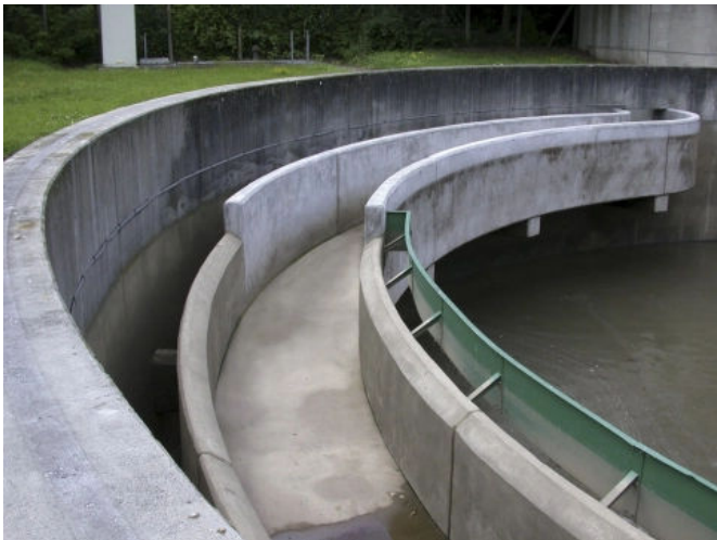
Beschichtungssystem für Kläranlagen Bingen-Büdesheim, DE. StoCrete TS 250, StoCrete TF 250. Foto: StoCretec
