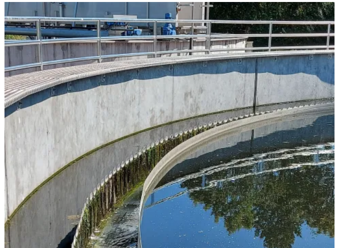
Nachklärbecken, Sanierung mit StoCrete TH 250, StoCrete TG 252, StoCrete TS 250, StoCrete TG 154, StoCrete TF 250, Kläranlage Nauheim, DE. Foto: StoCretec
