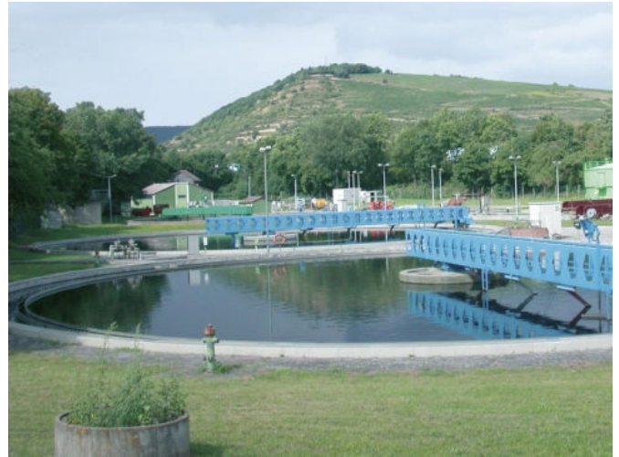
Kläranlage Bingen-Büdesheim, DE. StoCrete TS 250, StoCrete TF 250. Foto: StoCretec
