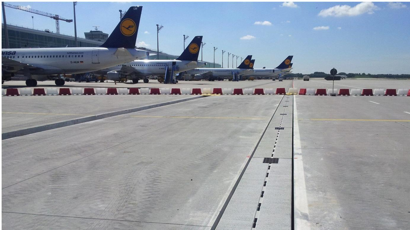
Die fundamentlose Entwässerungsrinne BIRCOport ist für maximale Belastungen konzipiert sowohl auf der Airside als auch auf Hafens- und Logistikflächen. Die großen Baulängen machen eine schnelle Verlegung bei geringer Fugenzahl möglich.
