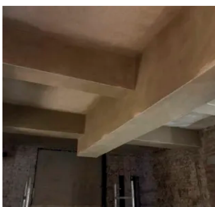
Kastenförmige Bekleidung von Deckenträgern
