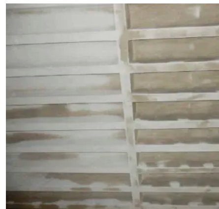
Reprofilerte Rippendecke
