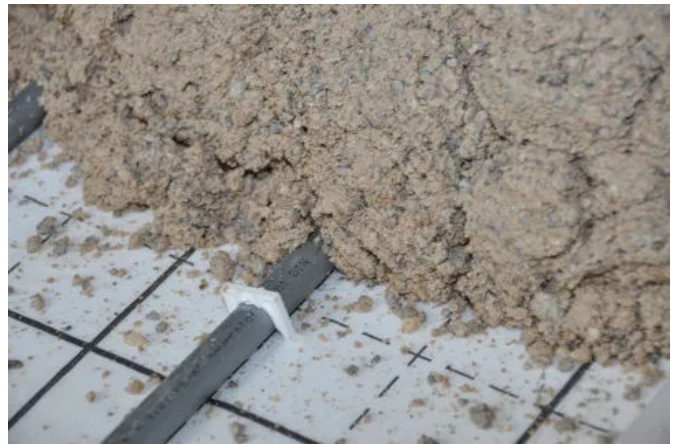
Konventioneller Calciumsulfatestrich auf Fußbodenheizung
