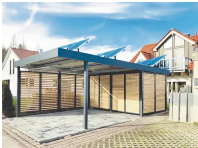
Bauseitige Photovoltaik auf Carport-Dach
