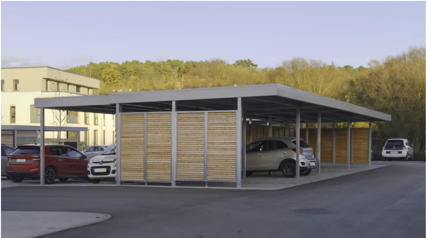
Carportanlage mit Wandelementen Füllung Holzlattung
