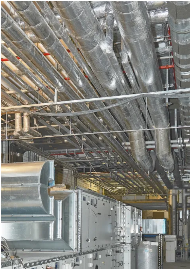
U Protect Rohrschalen aus ULTIMATE-Dämmstoff als 2-in-1-Lösung ermöglichen Brand- und Wärmeschutz von brennbaren und nichtbrennbaren Rohrleitungen und Rohrdurchführungen.
