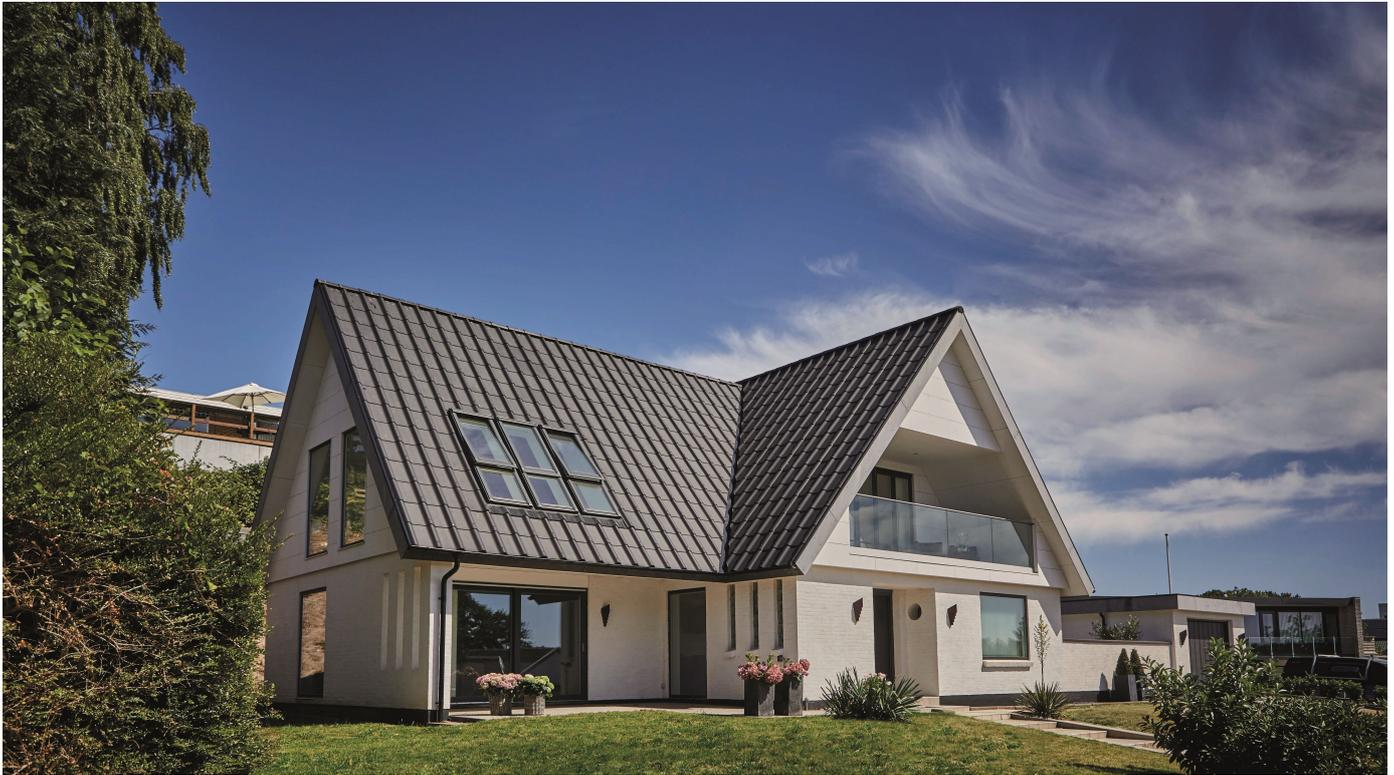
Die Dachplatte „Structa“ von Swisspearl ist für Dächern ab einer Neigung von 7° bestens geeignet. Dank des geringen Gewichtes lässt sich „Structa“ einfach verlegen.
