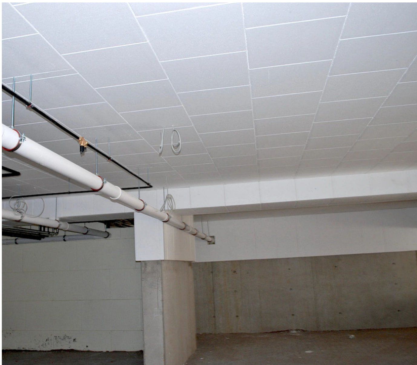
Tiefgaragendecke gedämmt mit Hirsch Porozell Deko-Dämmplatte 035 DI
