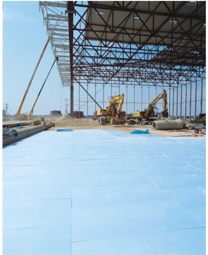
Wärmedämmung oberhalb der Bodenplatte
