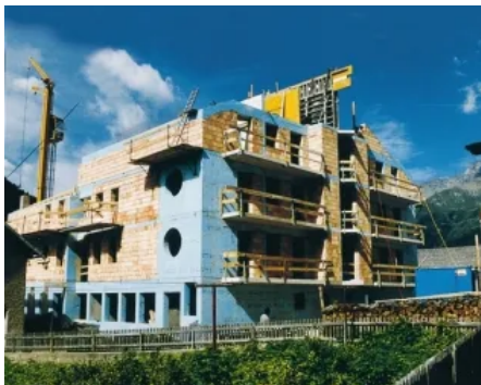
Wärmebrückendämmung
