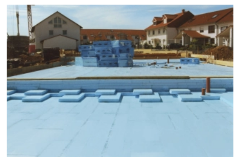
Verlegung der RAVATHERM™ XPS-Dämmplatten
