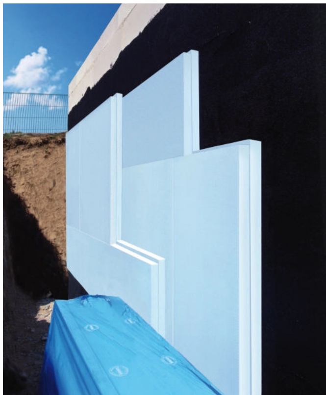
Mehrlagige Perimeterdämmung
