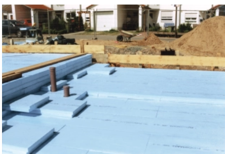
Verlegung der RAVATHERM™ XPS-Dämmplatten
