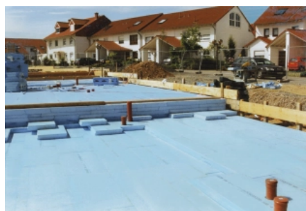
Verlegung der RAVATHERM™ XPS-Dämmplatten
