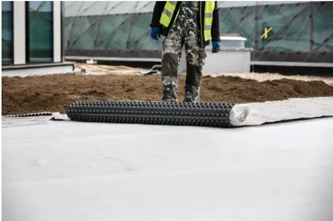
Die Oktagon-Noppe mit Verstärkungsrippen besitzt eine ca. 80 % höhere Druckfestigkeit als Standard-Noppen (© Photo: Martin Matula Photography)
