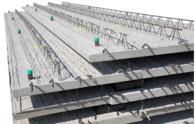
Vorgefertigte Fehr-Elementdecke
