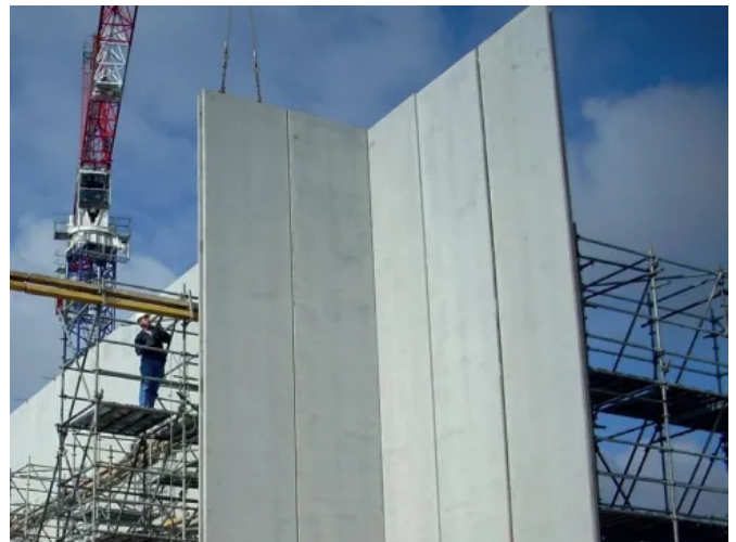
Montage der Fehr-Doppelwand
