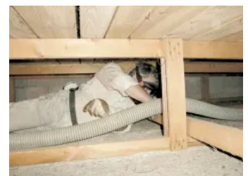
Nicht begehbare Geschossdecken lassen sich optimal mit Zellulosedämmung wärmetechnisch ertüchtigen.
