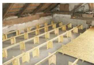
Deckenkonstruktion mit montierter Dämmständerkonstruktion WoodyFIX
