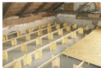
Deckenkonstruktion mit montierter Dämmständerkonstruktion WoodyFIX
