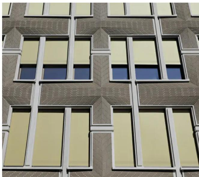
WAREMA Schacht-System-Markisen eignen sich für eine unsichtbare Integration in bauseits vorhandene Schächte oder Sturzkästen. Die Befestigung erfolgt über die Führungsschienen.
