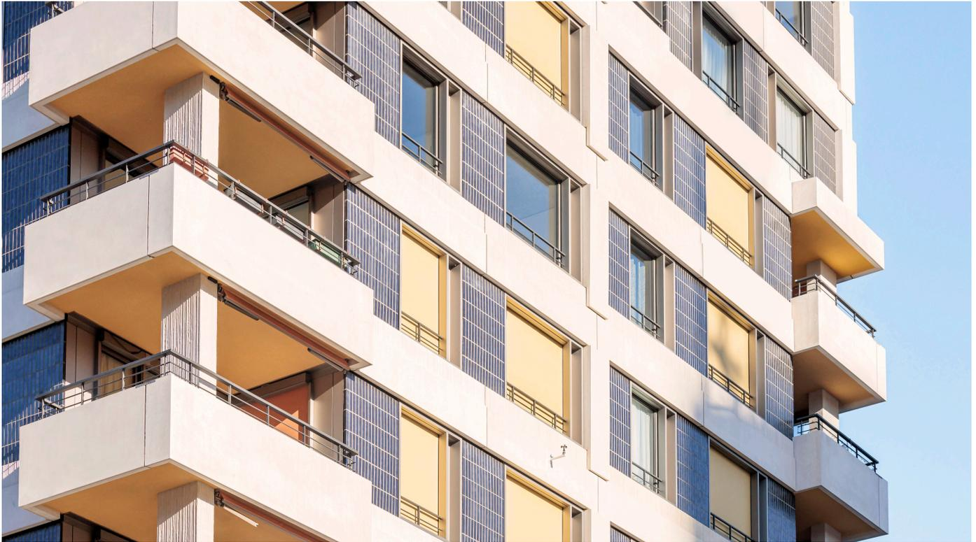
Fenster-Markisen von WAREMA sind ein textiler, außenliegender Sonnenschutz. Sie überzeugen nicht nur funktional durch Schutz vor Sonneneinstrahlung und Reduzierung des Energieverbrauchs, sondern auch ästhetisch durch die große Farb- und Stoffauswahl.
