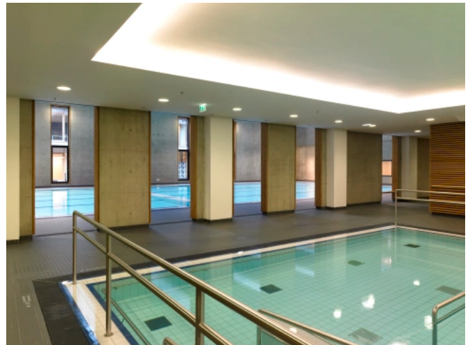
Für die Abdichtung unter Fliesen und Platten in Schwimmbädern stehen mineralische als auch Reaktionsharz-Systeme zur Auswahl.
