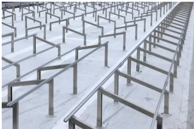
Abgeschlossene Montage der Aufständereien © Optigrün
