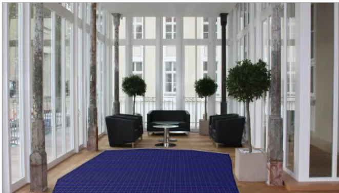
Darstellung der Kapillarrohrmatten Typ FOLIMAT auf Trockenbauuntergrund am Beispiel des ehem. Kaiserin-Augusta-Hospitals Berlin. © Karl Storz SE & Co. KG
