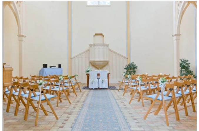
Fertiggestellter Fußboden mit integrierten Kapillarrohrmatten Typ OPTIMAT als Fußbodenheizung in der Alten Neuendorfer Kirche in Potsdam. © Melanie Bastian
