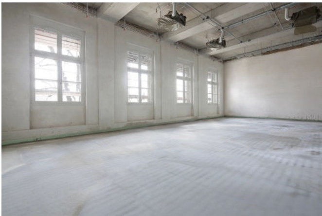
Verlegreife Oberfläche nach Einbringen der Nivelliermasse.
