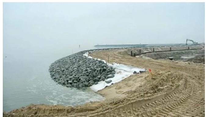
Deckwerksbau mit Secutex® H
