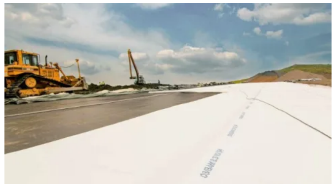
Deponiebasisabdichtungssystem mit Secutex® Geotextil
