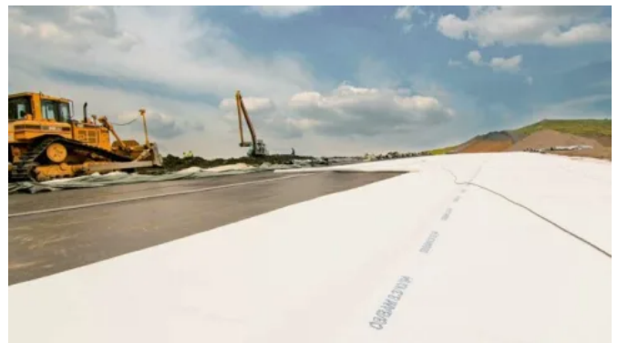
Deponiebasisabdichtungssystem mit Secutex® Geotextil
